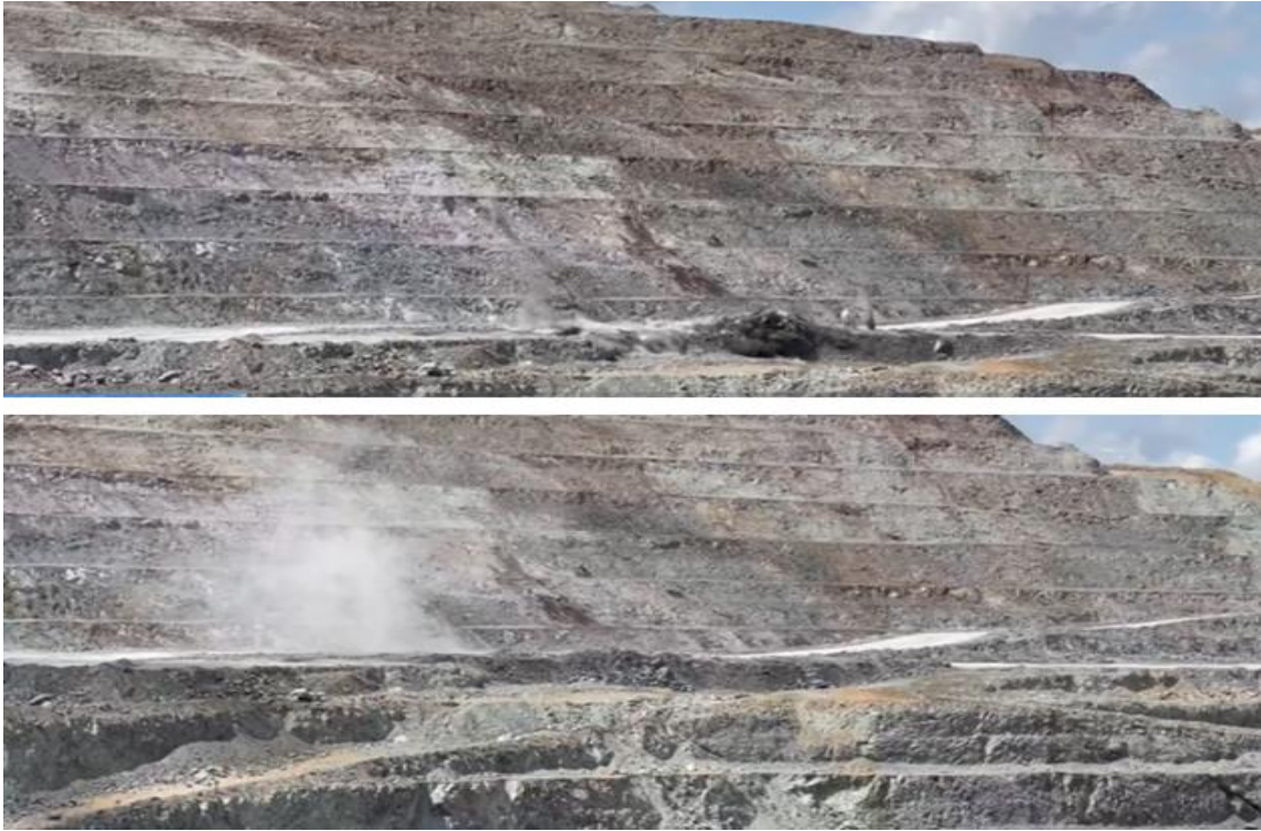
Şekil 3.20. Elektronik ateşleme sistemi ile yapılan patlatma anı ve sonrası
