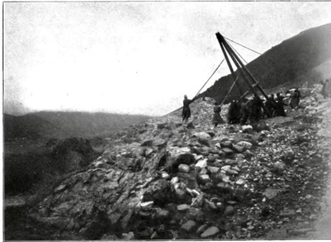
УСТАНОВКА ТРОЙНАГО ТЕЛЕГРАФНАГО СТОБА ВЪ ГОРСТНЫХЪ МѢСТАХЪ ТУРКЕСТАНСКАГО КРАЯ.
