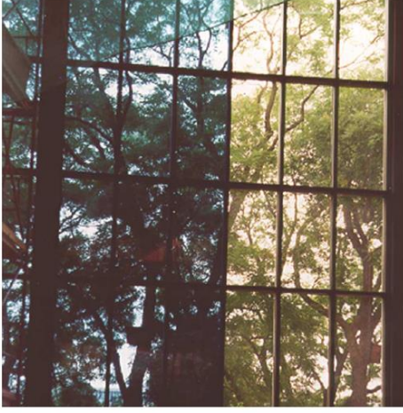
Şekil 1.1 Elektrokromizmin bazı uygulamaları a) elektronik kontrol özelliği olan mimari cam, b) Prototip elektrokromik cam.
