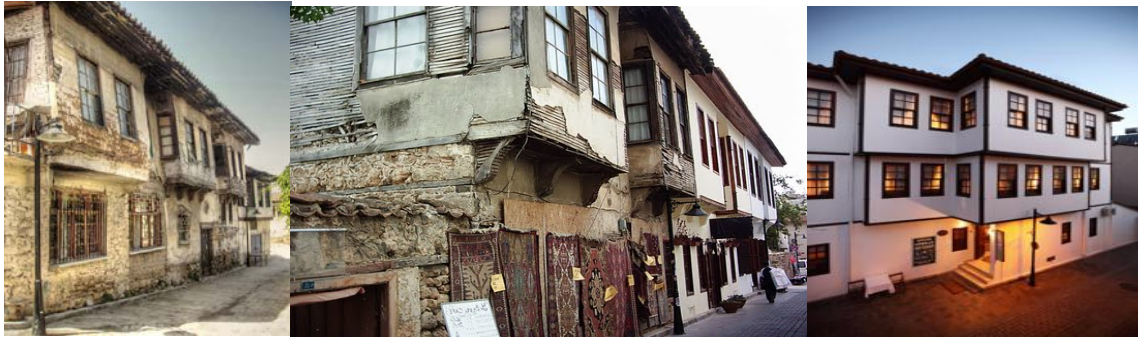
Şekil ( 273,274,275 ) Antalya Kaleiçi Mahallesi, Restore edilmemiş Yapı Örneği, Restore edilmiş yapı örneği
