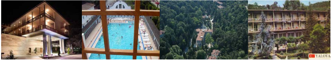
Şekil ( 49,50,51,52 ) Yalova Termal Oteli, Yeniden Yapım Projesi (2010 )
