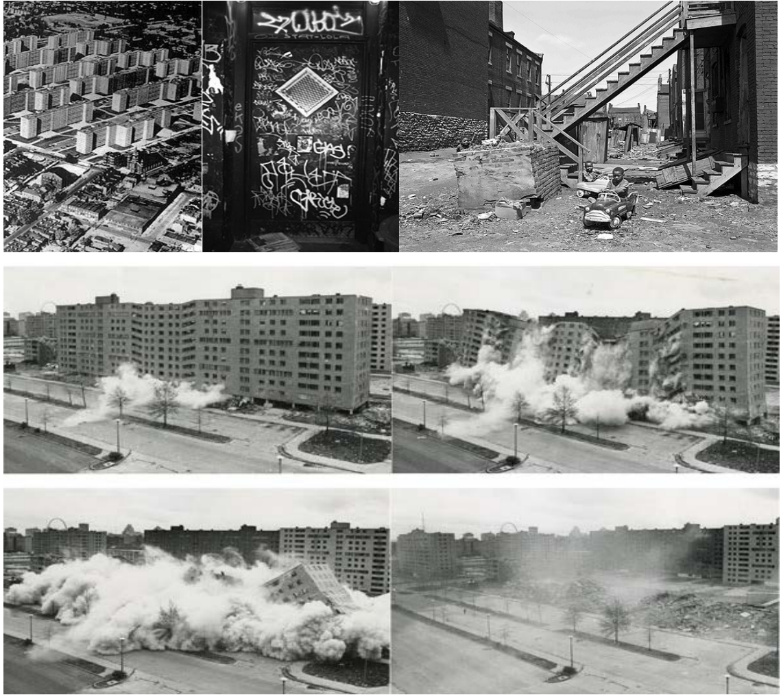
Şekil ( 199,200,201,202,203,204,205 ) Pruitt- Igoe, Yıkım Öncesi ve Sonrası Görünümler, “ İdeal Modernizm mi? Yoksa ‘Modern’ Gerçeklik mi? ” , “ Modernizmin Ölümü ”- Charles Jencks, 1959
