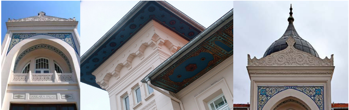
Şekil ( 39,40,41 ) Ankara Palas, Cephe ve Saçak altı Çini Bezeme Detayı
