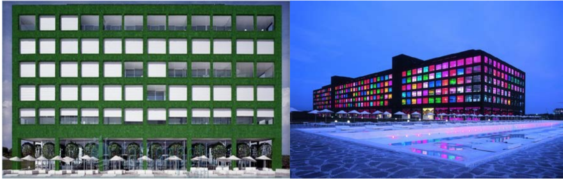
Şekil( 148,149 )Adam & Eve Hotel, Antalya, Belek, Sırasıyla Cephe Görünümü, Genel Görünüm
