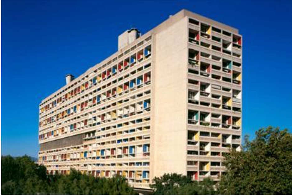
Resim 2.7. Unite d'Habitation (Görsel:www.fondationlecorbusier.fr)
