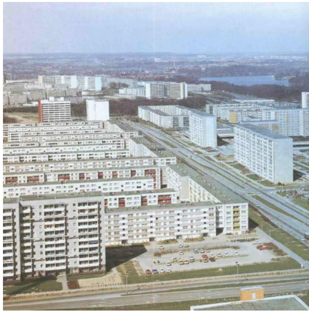
Resim 2.3. Bir Plattenbauten örneği (Görsel: http://veriweber.de/flucht-aus-plattenbauten/ )
