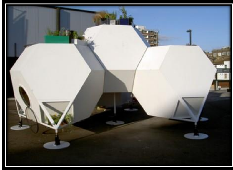
Resim 2.5. N55 yapısının görünümü
