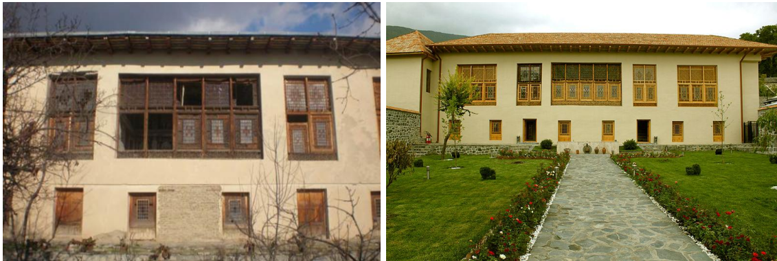
Şekil 74: Şeki Han Evi (restorasyondan önce ve sonraki hali) Şeki şehri, Azerbaycan (Kaynak: http://az.wikipedia.org )
