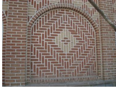
Yatay Dikey Tarzında Yapılan Tuğla İşlemleri
