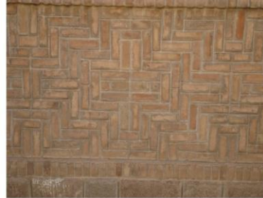
Yatay Dikey Tarzında Yapılan Tuğla İşlemleri
