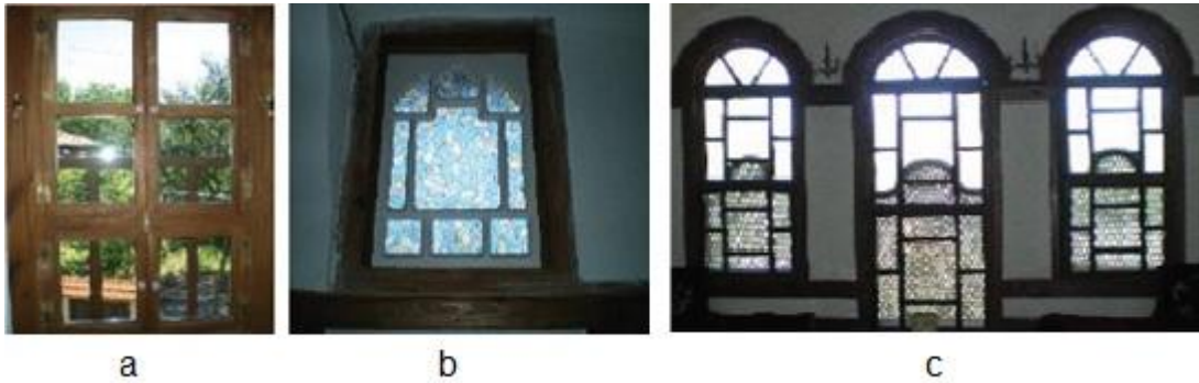
Şekil 111: (a) Safranbolu evlerinde kanatlı pencere, (b) tepe penceresi, (c) sofa- eyvan penceresi örneği (Kaynak: Bozkurt, 2009).
