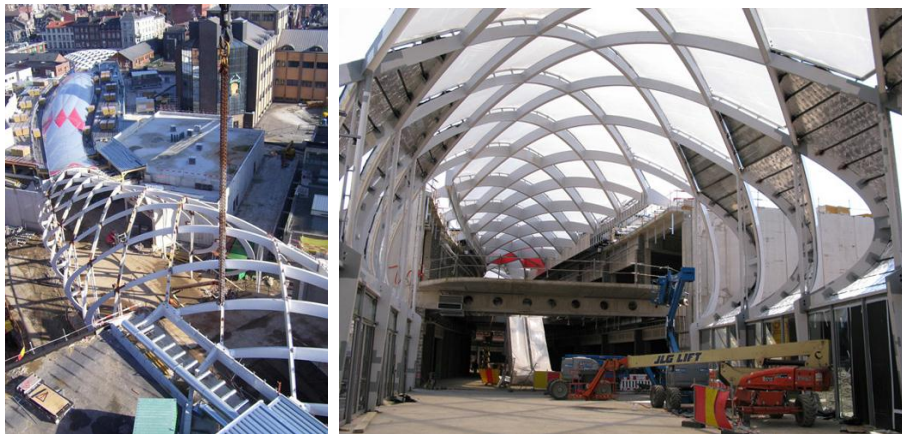
Resim 4.31. Mediacite AVM'de çelik kafesin inşa aşaması ( http://www.ronarad.co.uk )
