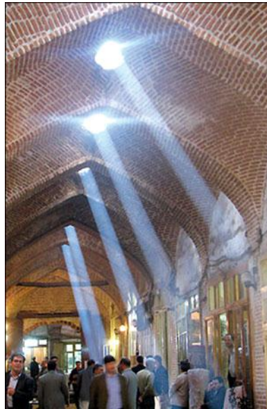
Resim 4.23. Tebriz Kapalıçarşısı'nda ritmik tepe açıklıklarına örnek,( http://fr.mobilytrip.com )
