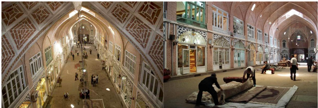
Resim 4.21. Tebriz Kapalıçarşısında ana aks tavan açıklıkları ve doğal aydlatması ( http://www.unesco.org )
