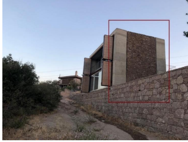
Görsel 55. B2 Evi Güneydoğu Cephesi
