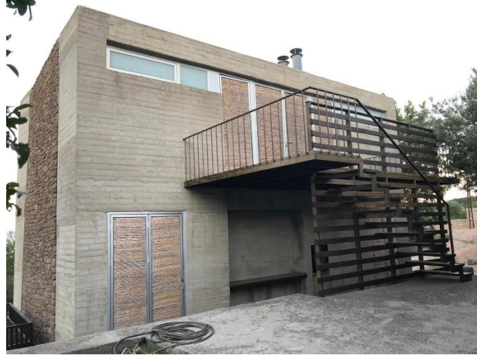
Görsel 57. B2 Evi Kuzeydoğu Cephesi
