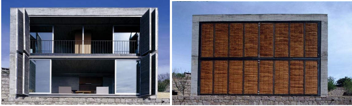
Görsel 53. Güneybatı Cephesi Açık Hali (URL 61) Görsel 54. Güneybatı Cephesi Kapalı Hali (URL 61)
