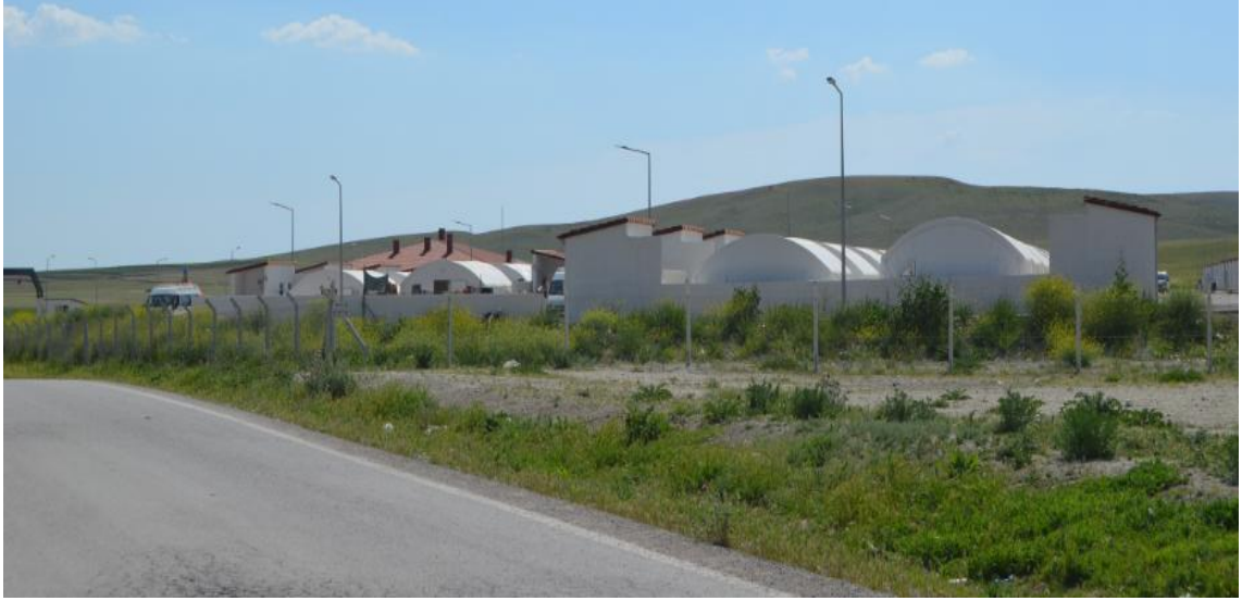
Görsel 73. Sarıoba Mevsimlik Tarım İşçileri Yerleşkesi – 2 (Araştırmacı tarafından çekilmiştir)
