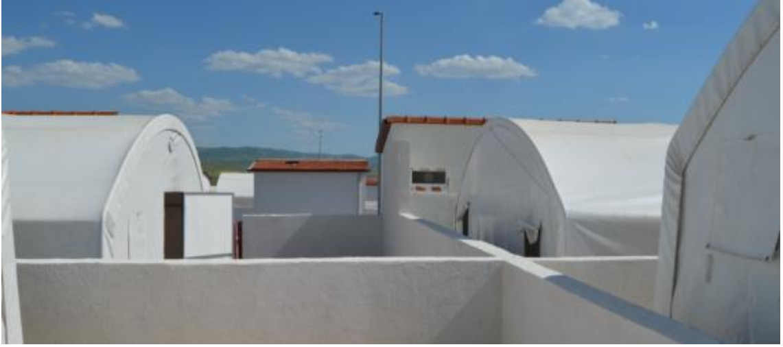
Görsel 84. Sarıoba Yerleşkesi Yaşam Alanlarını Ayıran Duvarlar (Araştırmacı tarafından çekilmiştir)
