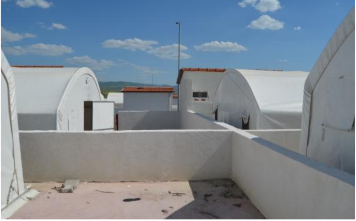
Görsel 106. Çadırlar Arası Beton Bölmeler (Araştırmacı tarafından çekilmiştir)
