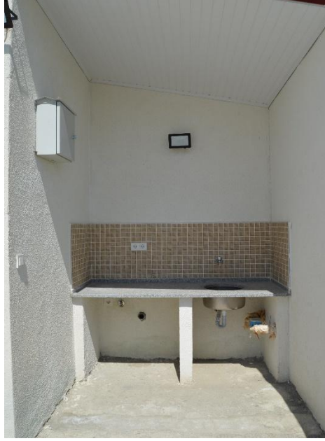
Görsel 115. Mutfak Bölümü – Eveye, Seramik, Prizler ve Aydınlatma (Araştırmacı tarafından çekilmiştir)
