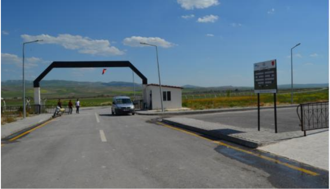
Görsel 101. Sarıoba Yerleşkesi Ana Giriş Kapısı İçeriden Görünüm (Araştırmacı tarafından çekilmiştir)
