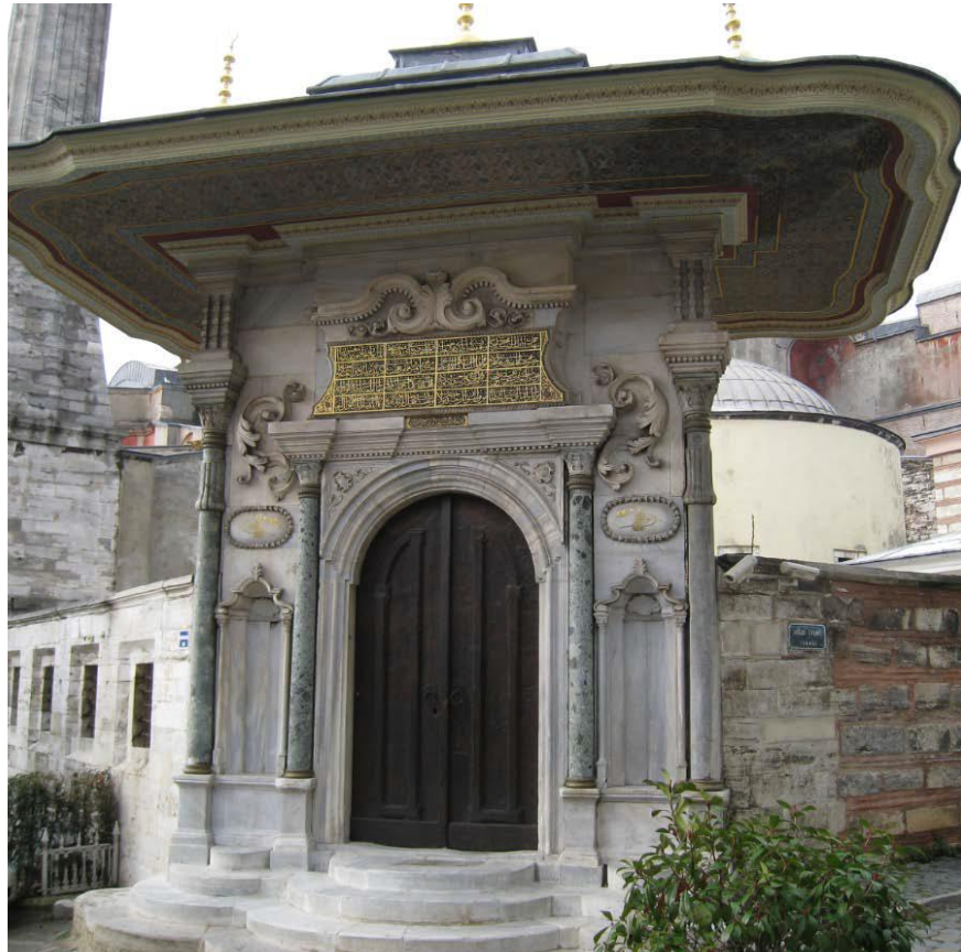
Resim 42. Ayasofya İmaretî'nin Merasim Kapısı, Kuzeydoğudan Görünüm (Karakaya, 2019)
