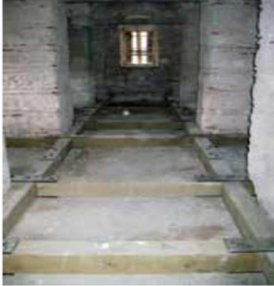
Resim 114. Bodrum Kat Döşemenin Altında Kurulan Ahşap Sistem (Ocakcan, 2013, s. 132)
