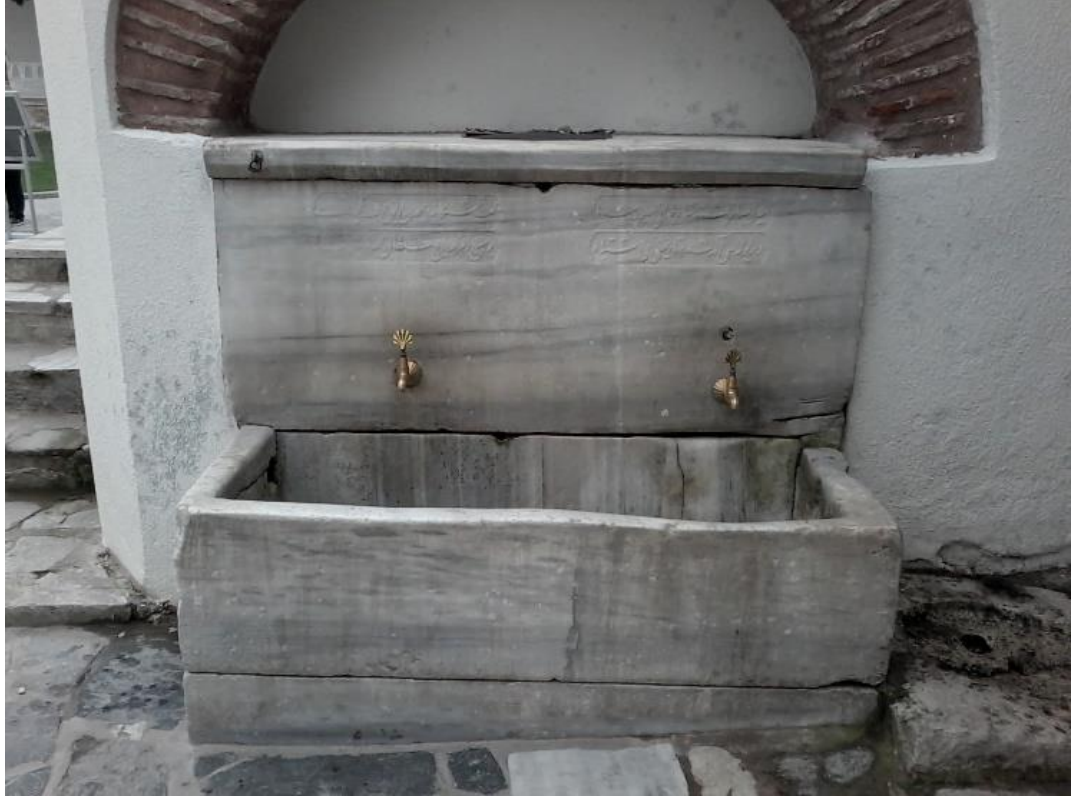
Resim 30. Topkapı Sarayı Kuşhane Kapısı I. Mahmud Çeşmesi (1735) (Karakaya, 2019)
