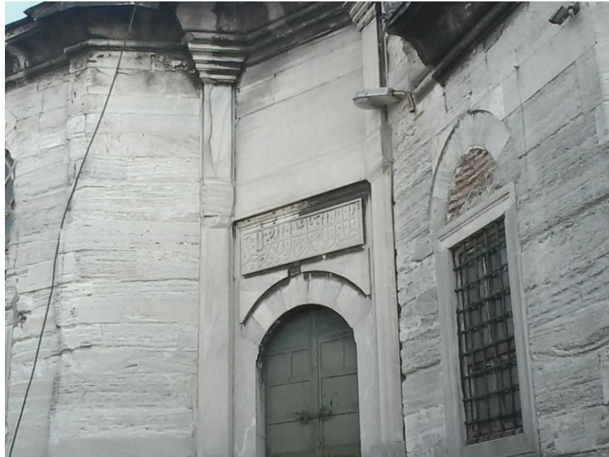
Resim 125. Nuruosmaniye Kütüphanesi Kuzey Kapısı (Hümayun Kapısı) (Karakaya, 2019)
