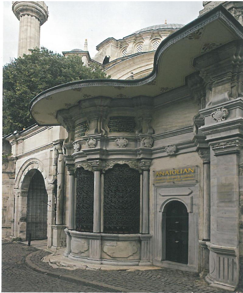
Resim 64. Nuruosmaniye Külliyesi, Batı Kapıdan Çeşme ve Sebîl'in Görünümü (Kuban, 2007, s. 519)
