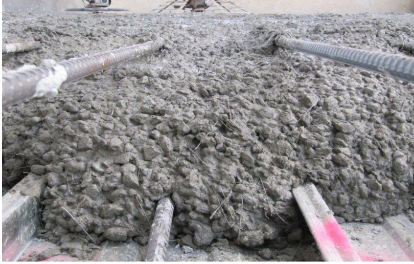
Şekil 2.12. İnşaatta kullanılan beton-demir kompozit [44]
