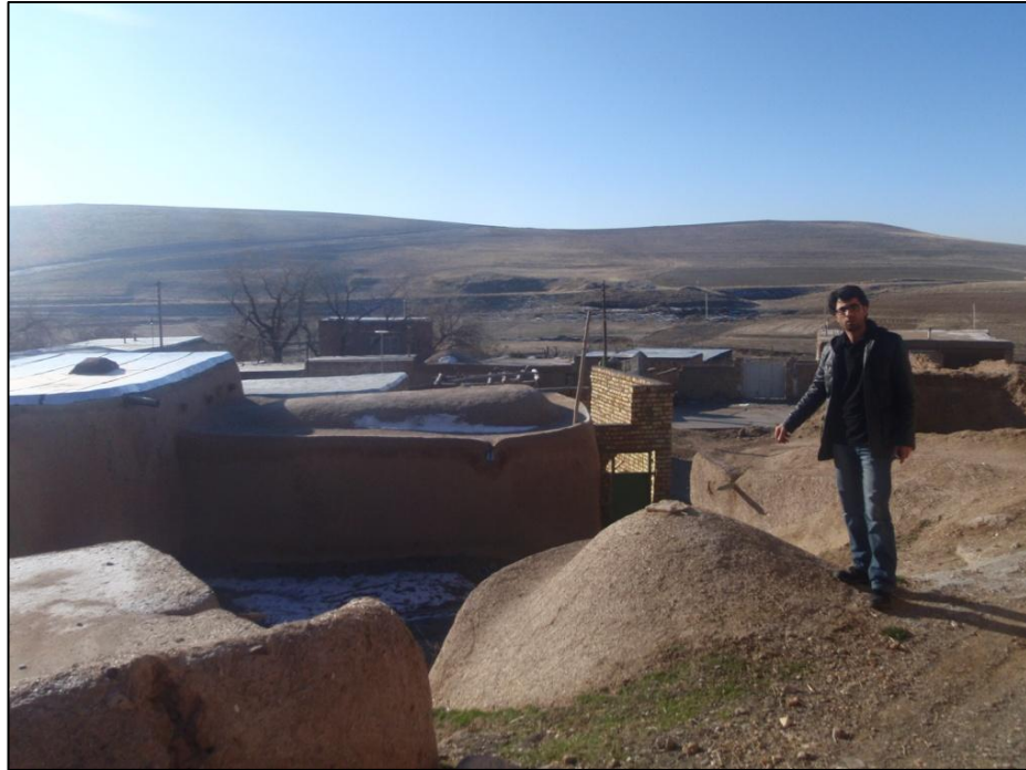
Segercug Köyü, Zağa denen bir hayvan ahırının çatısı. Zağalar sıcak ve güvenilir olsun diye tepelerde ve yer altında yapılmış. Dışa vurulu çatılarıyla Halaç hayvancılık kültürünün ayrılmaz unsuru olarak bilinmektedir.
