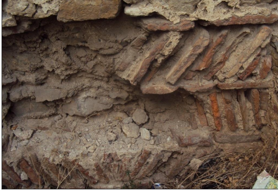
Şekil 159 : Eskihsar Kalesi, Kule 1, bacalı ocak nişinde tuğla bezeme detayı.
