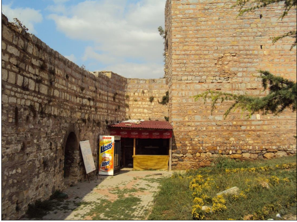
Şekil 96 : Eskihisar Kalesi, duvar 9 / 10, güneyden genel görünüm.
