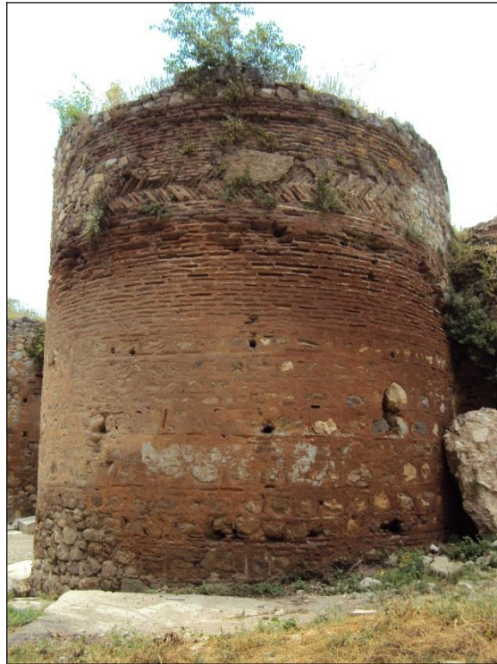
Şekil 118 : İznik, dış surları, Lefke kapısı batı kulesi.
