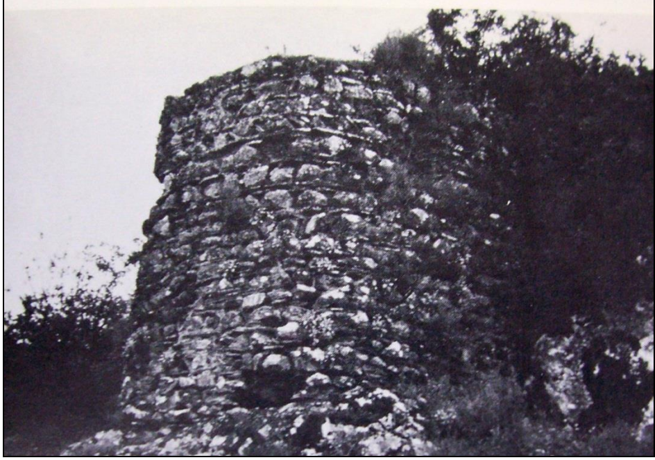
Şekil 119 : Nymphaeum Kalesi, İç Kaleyi ayıran duvardaki kule (Foss,1979, fig.19).
