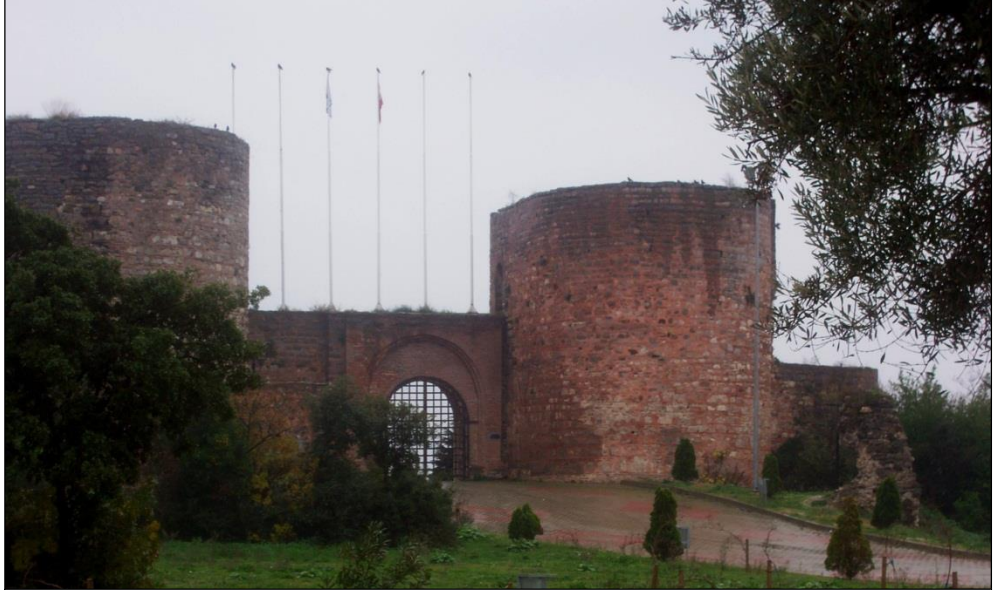
Şekil 98 : Eskihsar Kalesi, ana giriş, kuzeyden genel görünüm.
