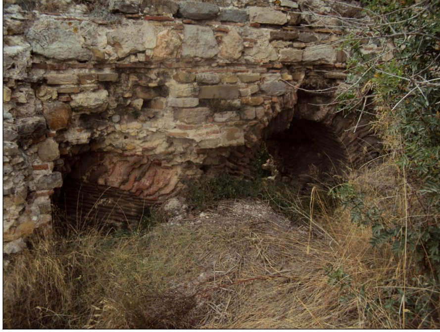
Şekil 16 : Eskihsar Kalesi, kule 1'in doğu duvarında, eksenin kuzeyindeki mazgal pencere ve güneyindeki giriş açıklığı
