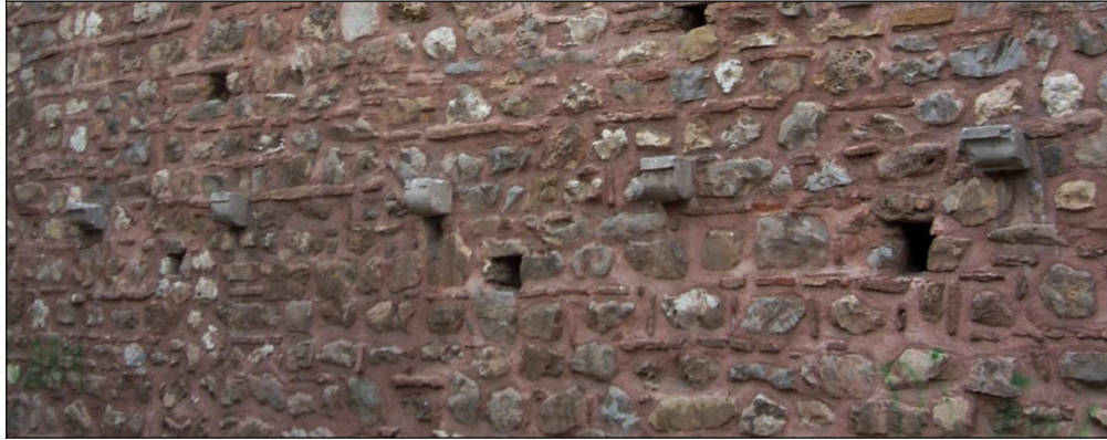
Şekil 47 : Eskihsar Kalesi, konutun kuzey duvarındaki 1.konsol sırası
