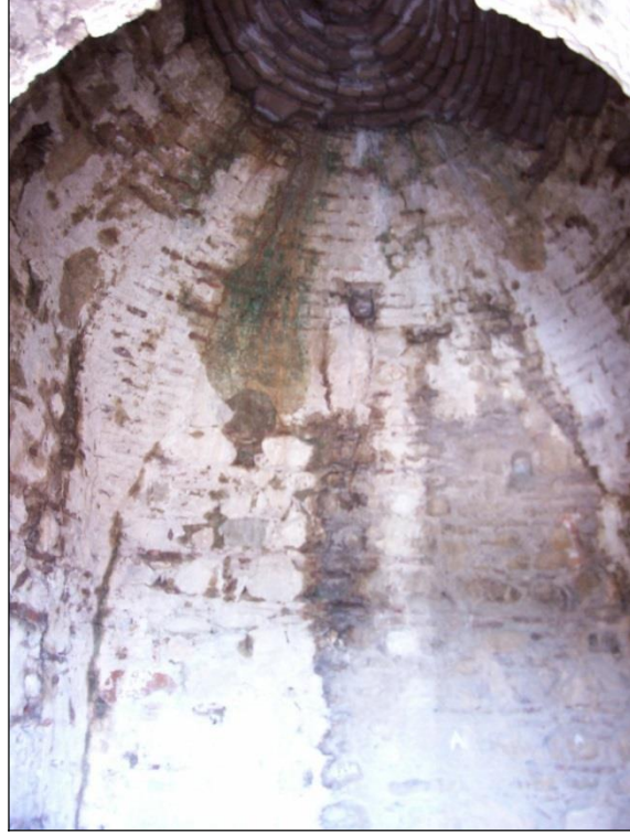
Şekil 107 : Eskihisar Kalesi, kule 11'in mekanını örten tonoz.
