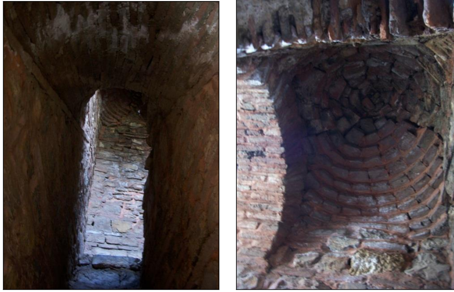
Şekil 100 ve 101 : Eskihişar Kalesi, kule 10, merdiven ve onarılmış olan tonozu.
