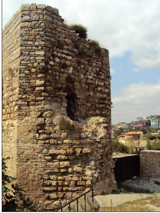
Şekil 105 : Eskihsar Kalesi, kule 11, güneydoğudan genel görünüm.
