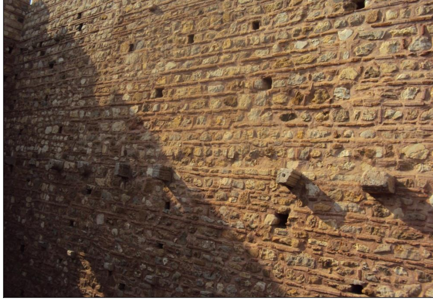
Şekil 46 : Eskihsar Kalesi, konutun kuzey duvarındaki 2. konsol sırası.
