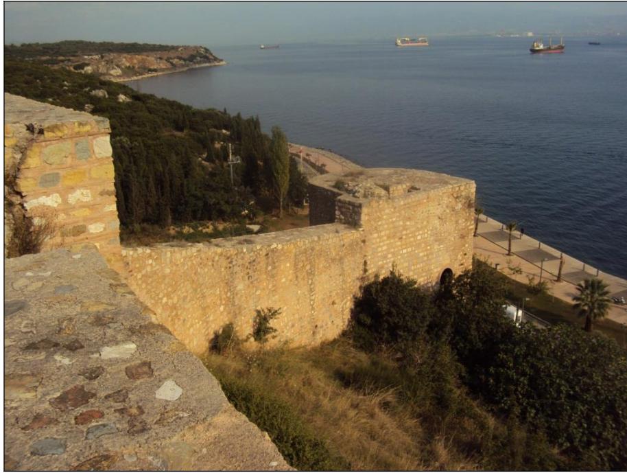
Şekil 79 : Eskihsar Kalesi, duvar 4 / 5 kuzeybatıdan genel görünüm.
