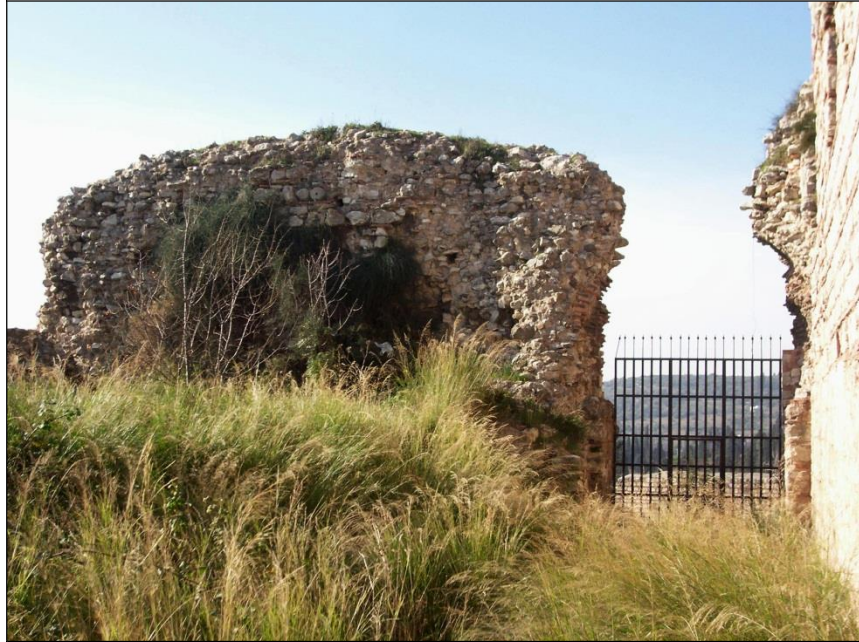
Şekil 65 : Eskihsar Kalesi, duvar 3 / konut, doğudan genel görünüm.
