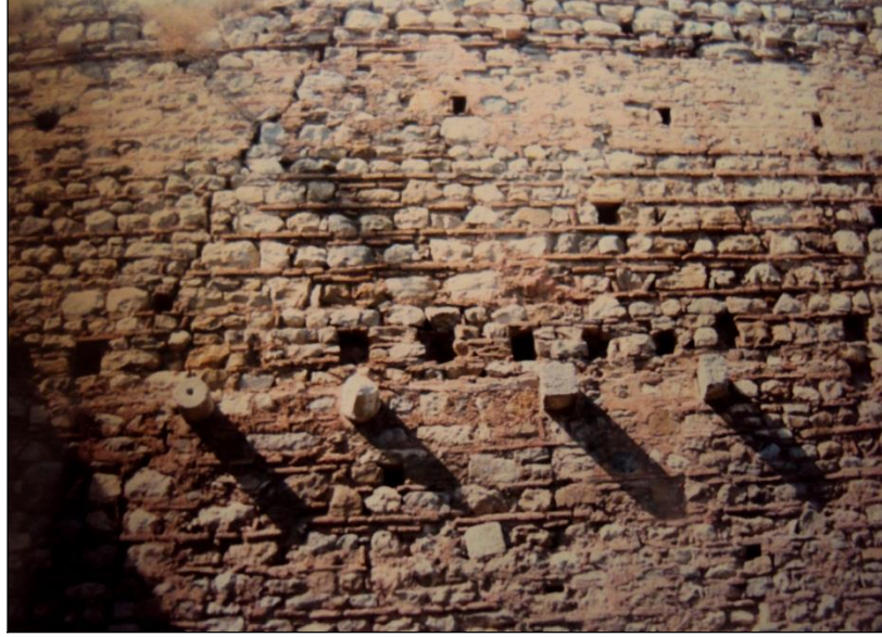
Şekil 122 : Konutun kuzey duvarındaki, onarım sırasında kapatılan giriş yuvaları.
