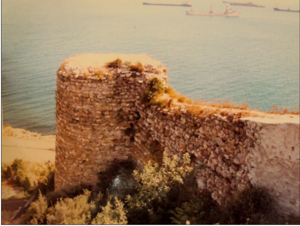
Şekil 80 : Eskihisar Kalesi, kule 5'in kuzey cephesi ve duvar 4/5'in doęu cephesinin onarım öncesi durumu (İzmit Arkeoloji Müzesi Arşivi, 1994).
