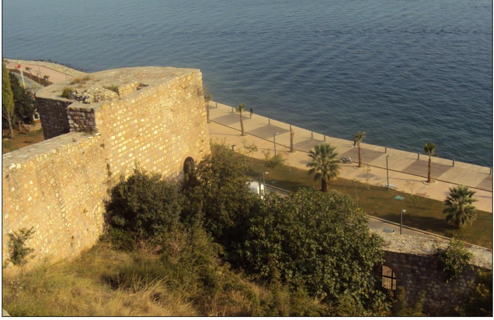
Şekil 82 : Eskihsar Kalesi, kule 5'in kuzeyden genel görünümü.
