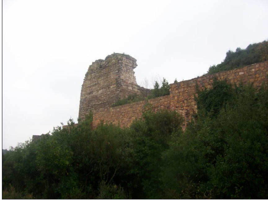
Şekil 114 : Eskihişar Kalesi, dış surun kuzey bölümü.
