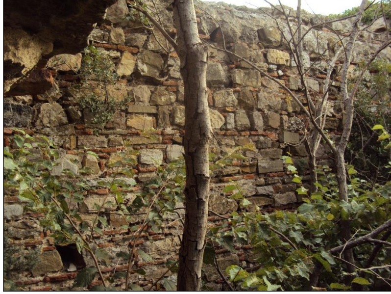
Şekil 22 : Eskihsar Kalesi, duvar1/2'nin kuzeyden genel görünümü.
