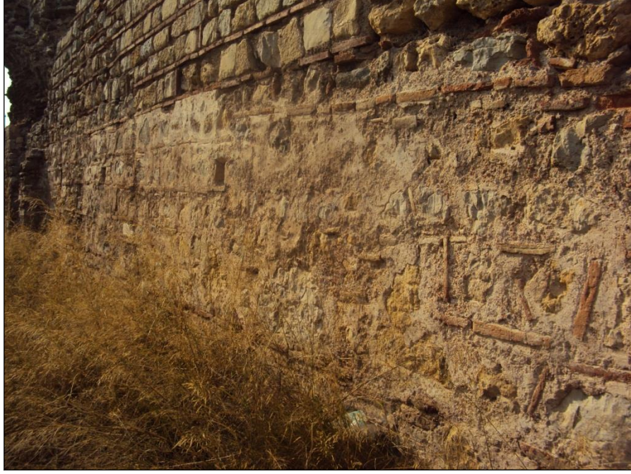
Şekil 64 : Eskihsar Kalesi, konutun güney cephesinde sıvalı duvar yüzeyi.
