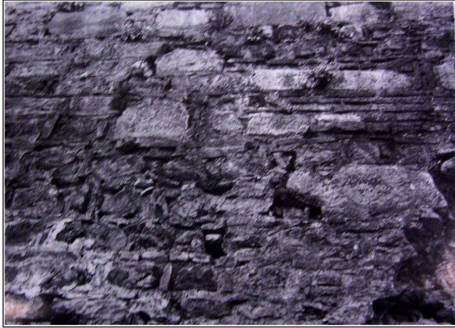
Şekil 162 : Manisa, Magnesia surları alt duvarlar, malzeme-tekniĖ detay (Foss, 1979, fig.14).
