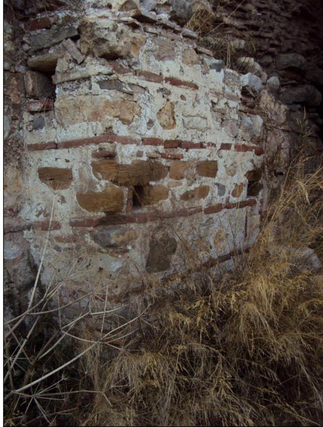
Şekil 33 : Eskihsar Kalesi, konutun kuzeydoğu cephesine bitişik duvar payesinden malzeme, teknik detay.
