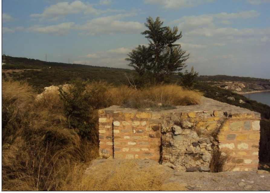
Şekil 74 : Eskihsar Kalesi, duvar 3 / 4, güneybatıdaki açıklık.
