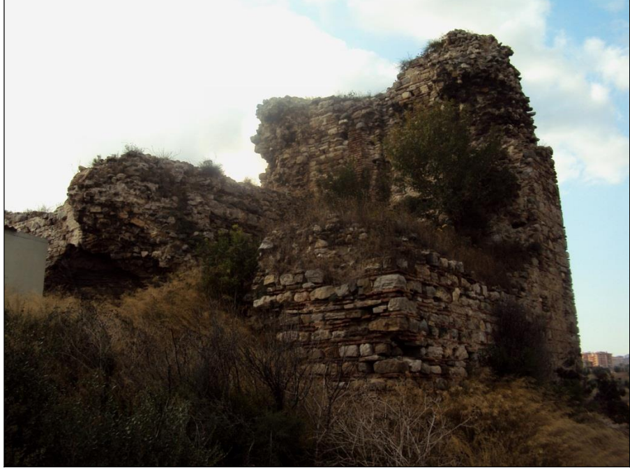
Şekil 14 : Eskihsar Kalesi, kule 1, güneydoğudan genel görünüm.
