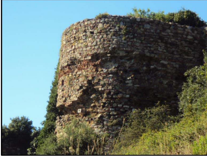
Şekil 166 ve 167 : İstanbul, Yoros Kalesi, bölme suru, kule ve malzeme-teknik detay.
