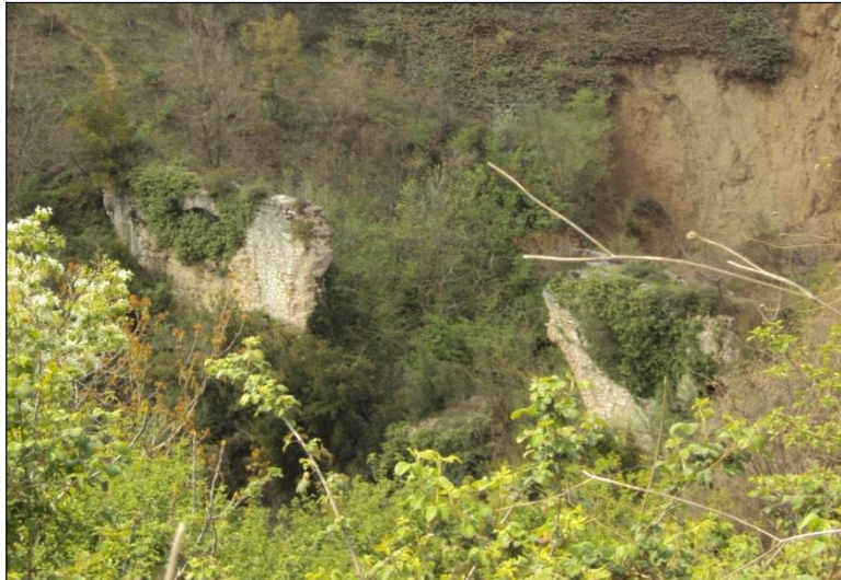
Şekil 3 : Paşasuyu su kaynağından, kente doğru inşa edilmiş olan su kemerlerinin, Malta Mahallesi'ndeki, Bizans döneminde inşa edilen bölümü.
