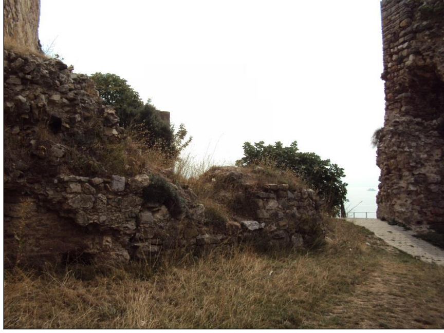
Şekil 109 : Eskihsar Kalesi, duvar 11 / konut, kuzeyden genel görünüm.
