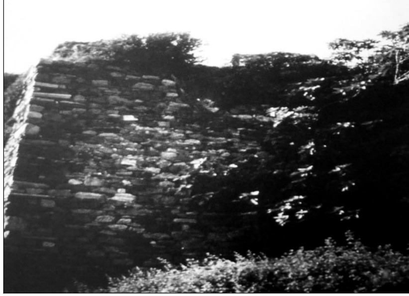
Şekil 137 :İstanbul, Yoros Kalesi, dörtgen planlı kulenin kuzey cephesindeki üçgen motifi (Eyice, 1976).
