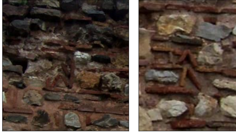
Şekil 63 : Eskihsar Kalesi, konutun batı cephesindeki tuğla bezemeler, detay.
