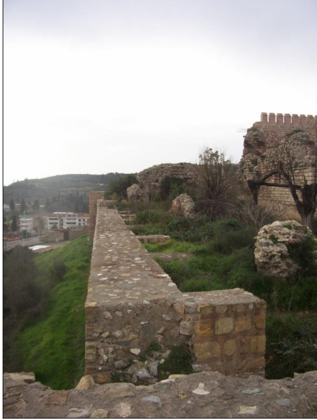
Şekil 73 : Eskihsar Kalesi, duvar 3 / 4 doğudan genel görünüm.
