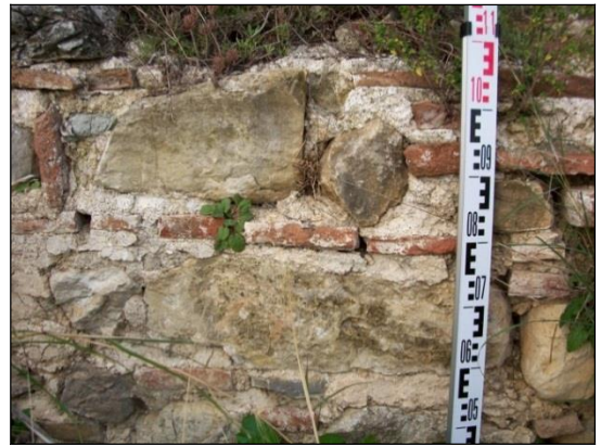
Şekil 149 ve 150 : Eskihisar Kalesi, iç kalenin kuzey duvarına bitişik arkosolyum, malzeme-teknik detay.
