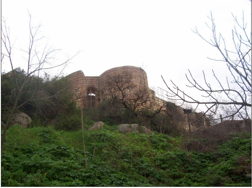
Şekil 92 : Eskihsar Kalesi, kule 8'in güneybatıdan görünümü.
