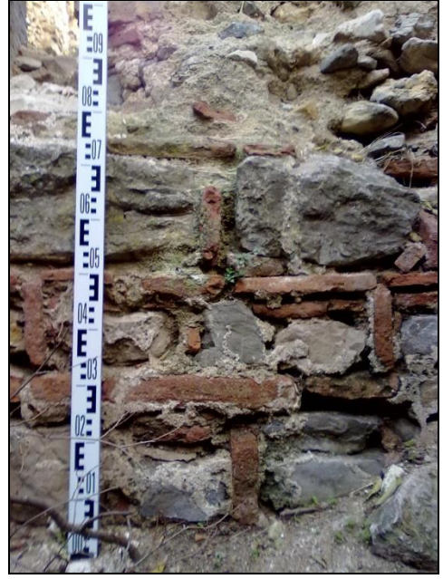
Şekil 155 ve 156 : Eskihişar Kalesi, İç Kale, kuzey kapı ve Kule 1'in batı cephesinden çerçevesel teknik detayları
