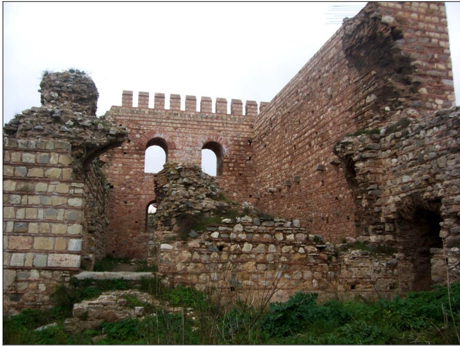
Şekil 35 : Eskihsar Kalesi, konutun doğu cephesi genel görünüm.
