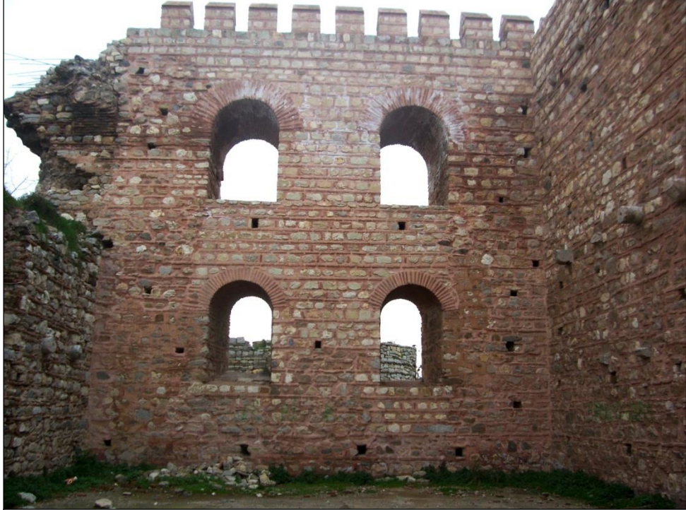
Şekil 39 : Eskihsar Kalesi, konutun batı duvarındaki pencereler, iç görünüm.
