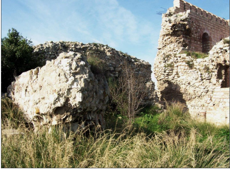
Şekil 66 : Eskihsar Kalesi, duvar 3 / konut, güneydoğudan genel görünüm.
