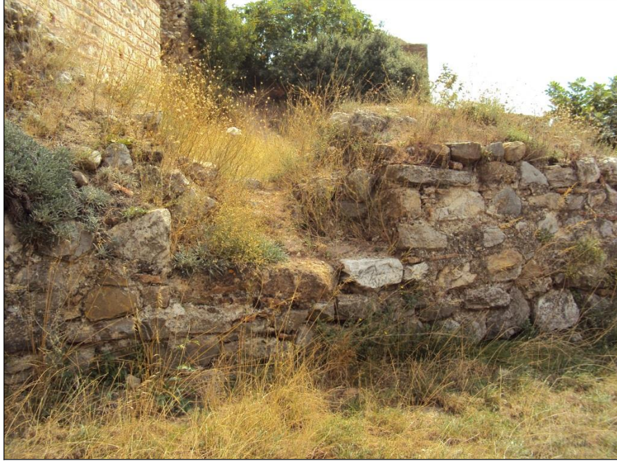
Şekil 110 : Eskihsar Kalesi, duvar 11 / konut, üzerindeki giriş açıklığı.
