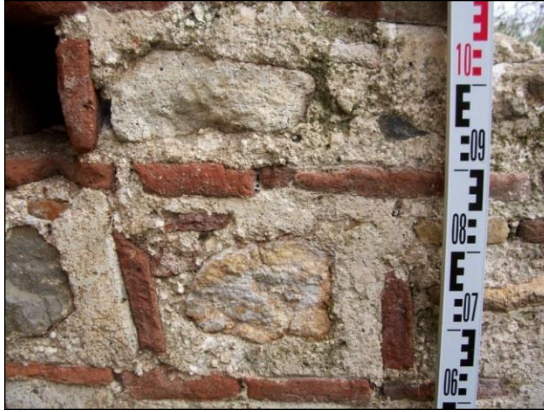
Şekil 149 ve 150 : Eskihisar Kalesi, iç kalenin kuzey duvarına bitişik arkosolyum, malzeme-teknik detay.
