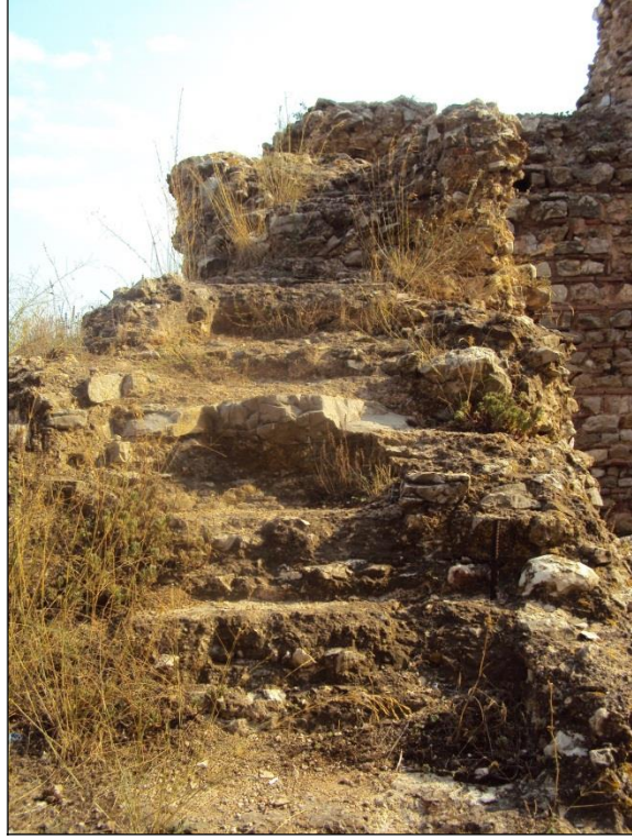
Şekil 44 : Eskihsar Kalesi, merdivenin kuzeyden genel görünümü.
