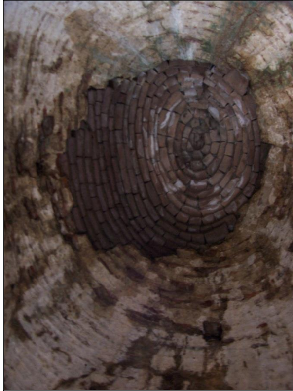
Şekil 102 : Eskihişar Kalesi, kule 10'nun dikdörtgen planlı mekanını örten eliptik tonoz.
