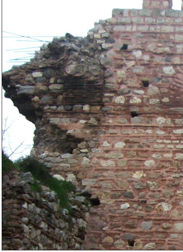
Şekil 40 : Eskihisar Kalesi, konutun güneybatı köşesindeki tonoz kalıntısı.
