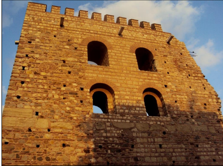
Şekil 59 : Eskihisar Kalesi, konutun batı cephesindeki tuğla bezemeler.
