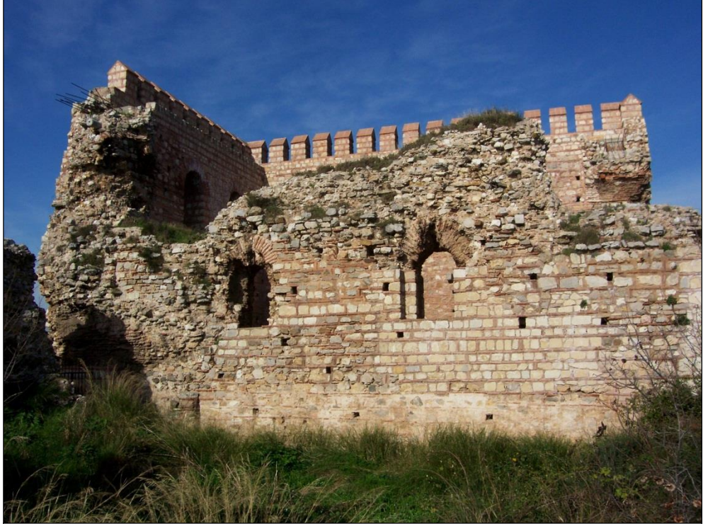
Şekil 34 : Eskihsar Kalesi, konutun güney cephesi, genel görünüm.
