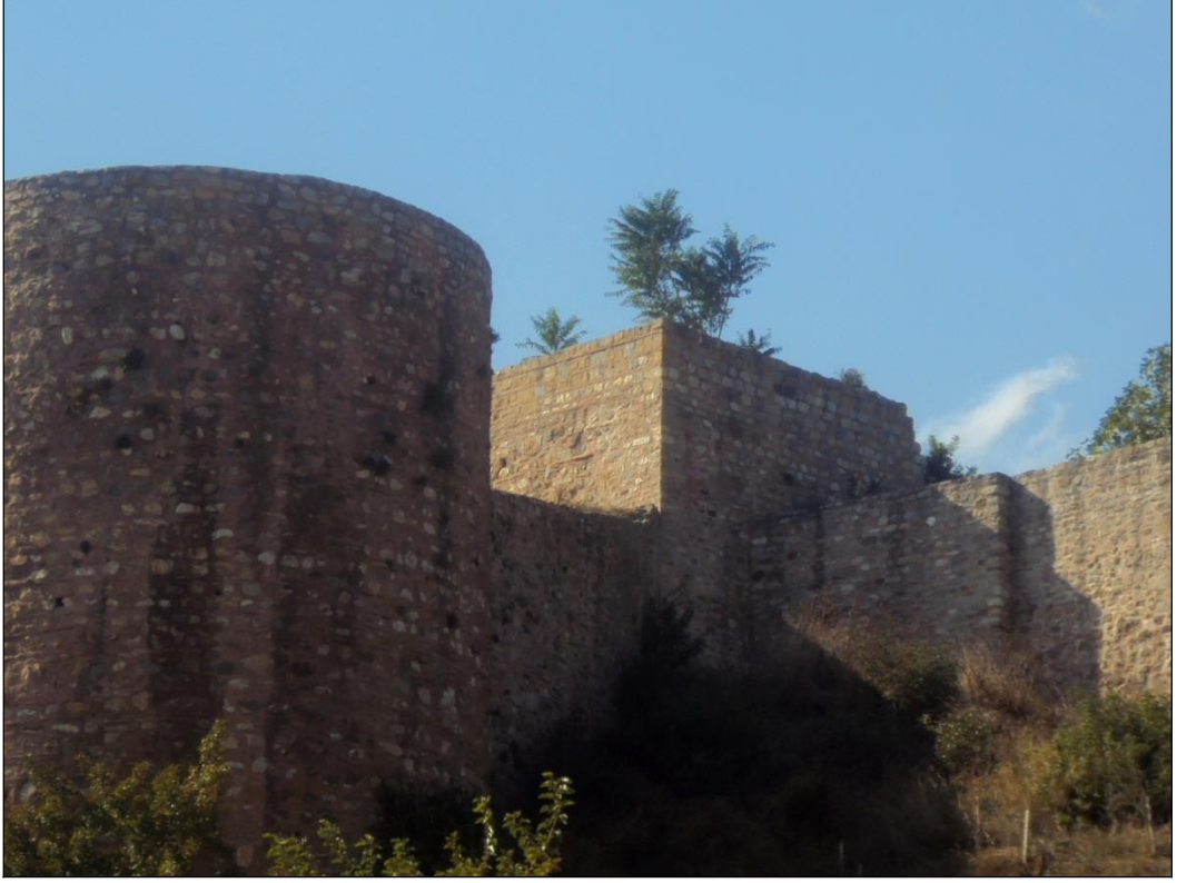
Şekil 76 : Eskihsar Kalesi, kule 4 güneydoğudan genel görünüm.
