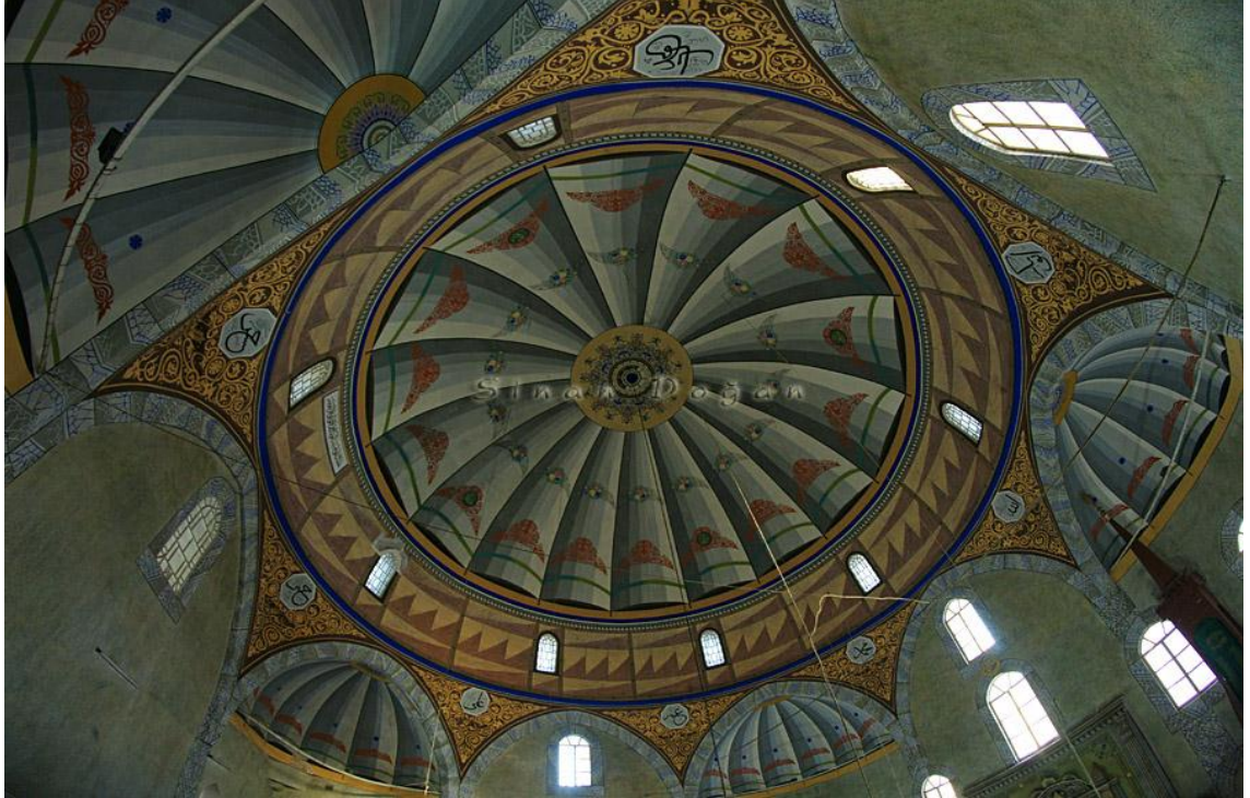
Levha 35: Kubbeye Geçiş Elemanı Tromplardan ve Kubbeden Ayrıntı
