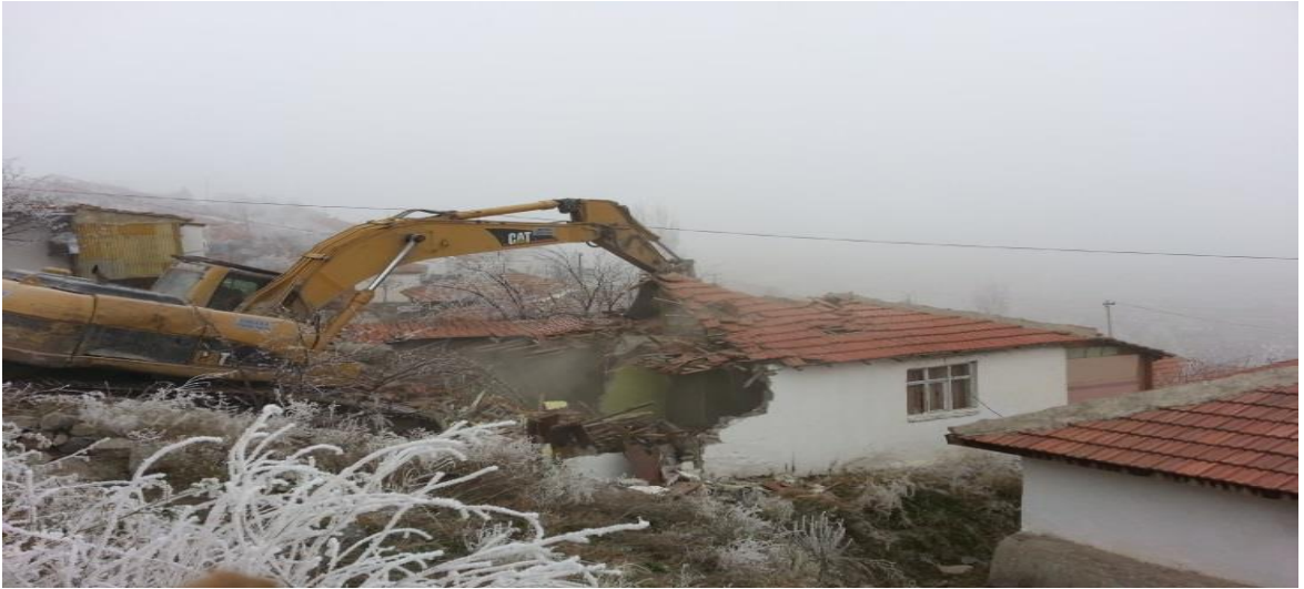
Şekil 4.4. İş makinesi ile yıkım işlemi.
