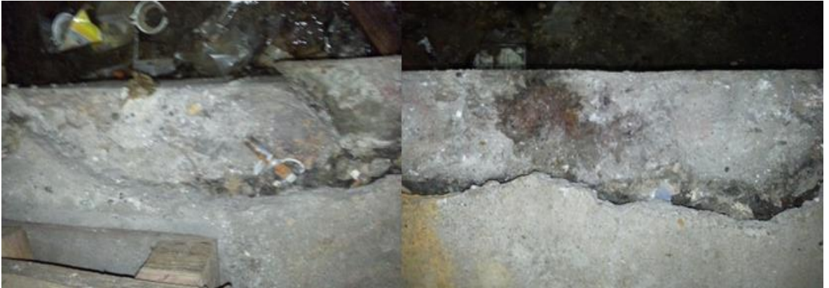
Şekil 5.8. Kazan dairesinin betonarme zemini.
