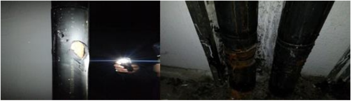
Şekil 5.10. Boru izolasyon malzemesi ve boru çeperi.
