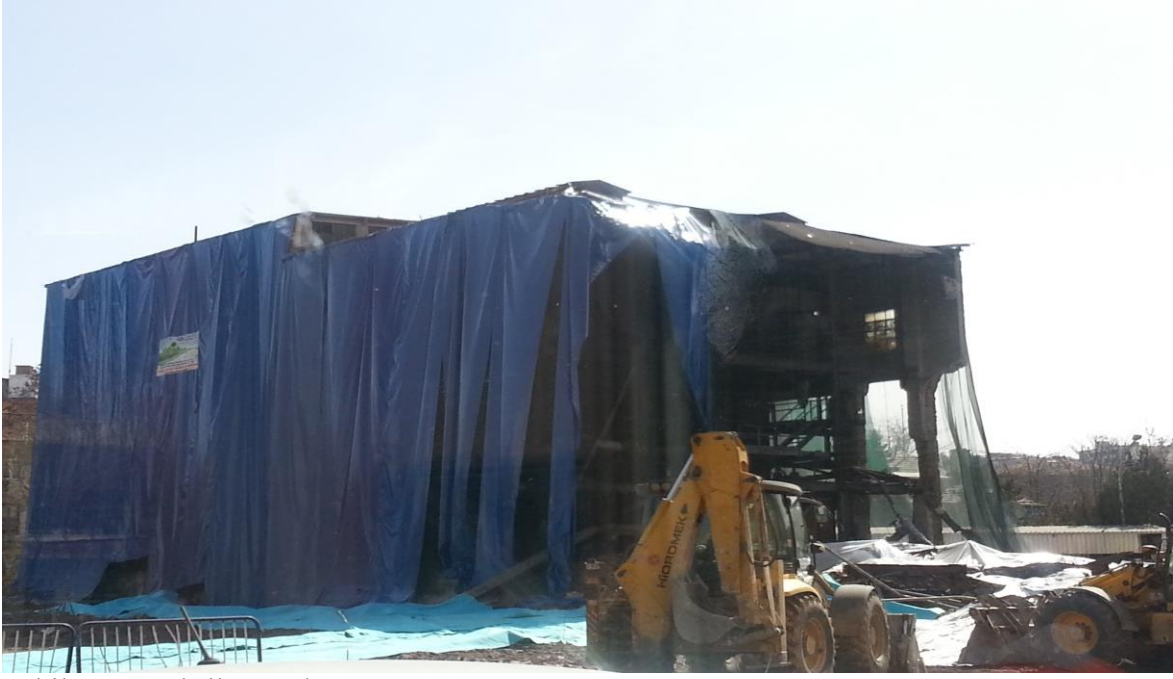
Şekil 4.10. Fabrikanın dış görüntüsü.
