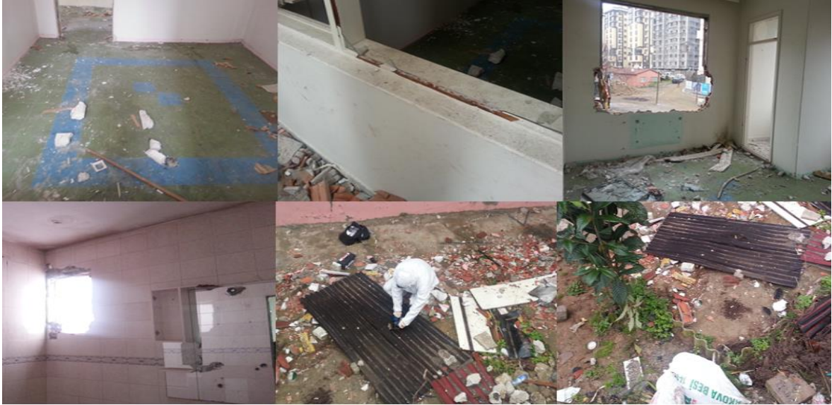
Şekil 5.16. Ataşehir’deki binadan numune alınan yerlere ait görseller.
