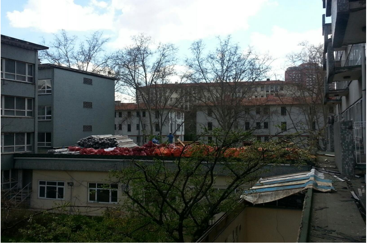
Şekil 4.2. Ek binanın görüntüsü ve asbestli çatı malzemelerinin paketlenmesi.
