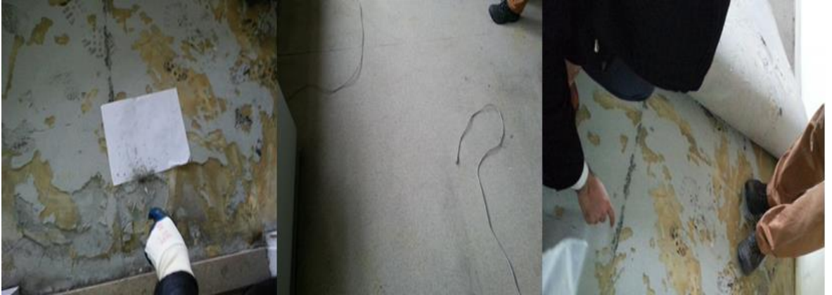
Şekil 5.7. Plastik yer kaplama malzemesi ve siyah renkli yapıştırıcı.
