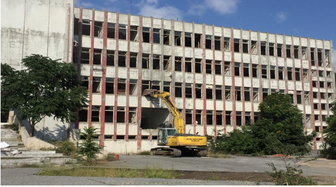
Şekil 4.13. Yıkım çalışmasına ait görüntü.
