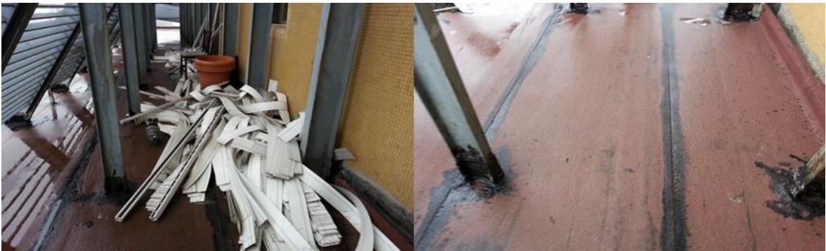
Şekil 4.7. Çatı kaplama malzemeleri ve çatı zemini.
