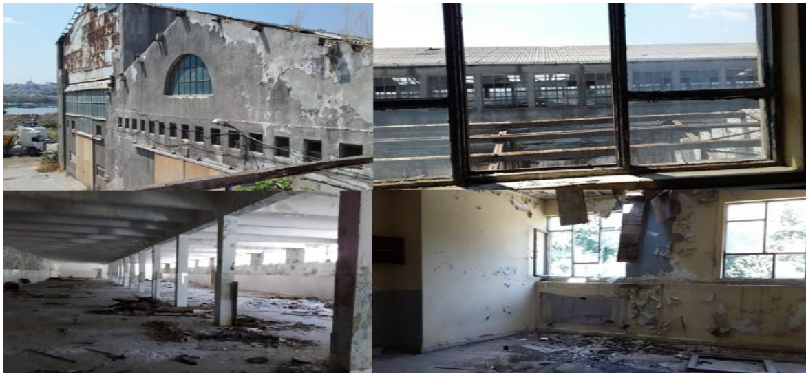
Şekil 4.17. Tersanede ikinci asbest söküm alanına ait görüntüler.
