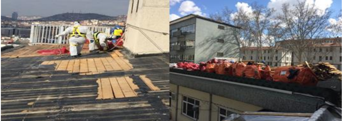
Şekil 5.4. Çatı izolasyon malzemelerinin sökülmesi ve paketlenmesi.
