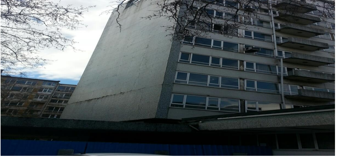
Şekil 4.1. Binanın dış görüntüsü.
