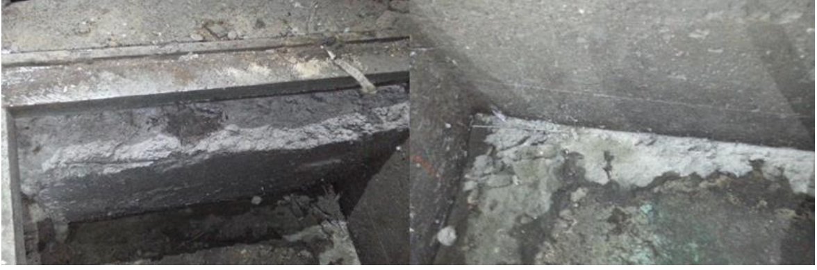
Şekil 5.9. Jeneratör dairesi betonarme zemini.
