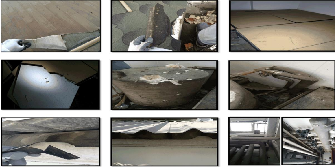
Şekil 5.1. Numune alınan yerlere ait görseller.
