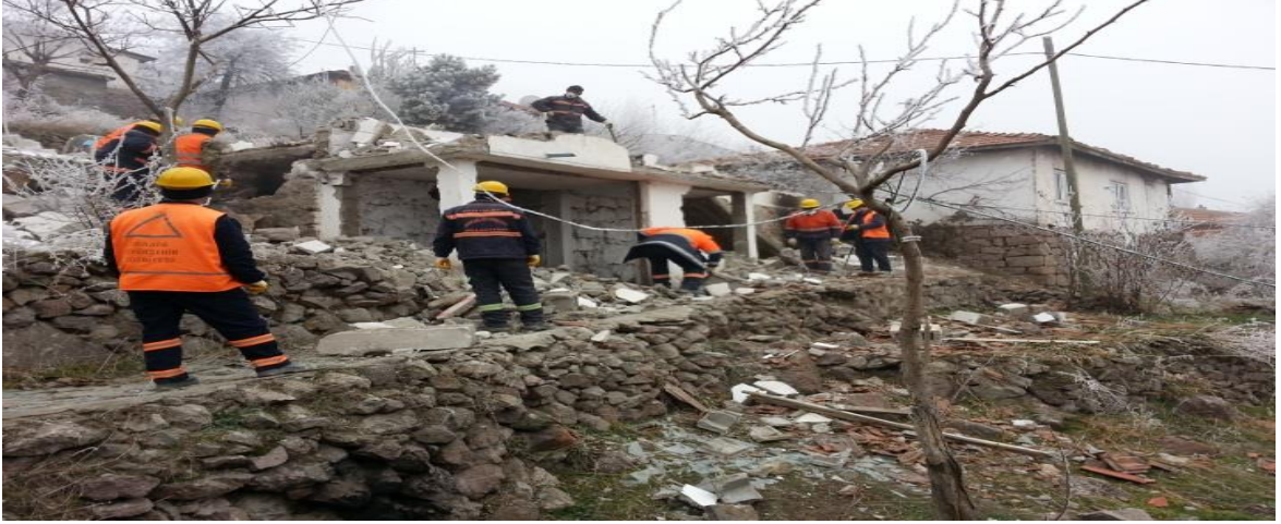
Şekil 4.3. Elle yıkım işlemi.
