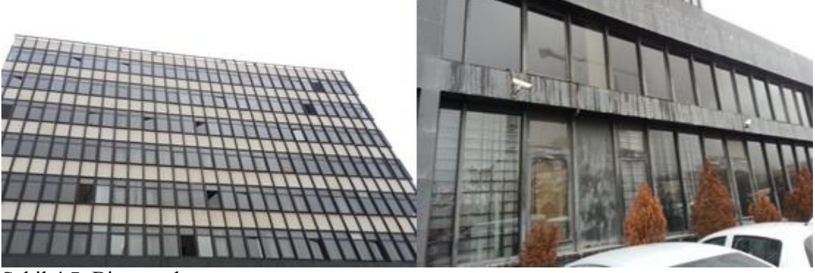
Şekil 4.5. Binanın dış görüntüsü.
