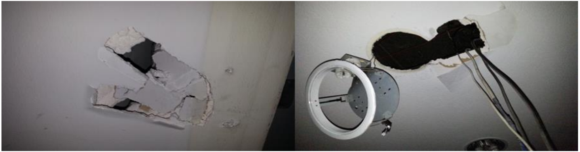
Şekil 4.9. Duvar ve tavan kaplama malzemeleri.
