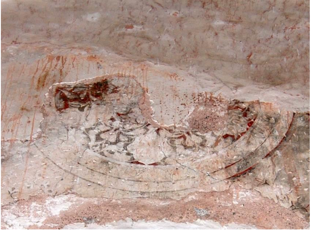
Fotoğraf 103. İç Avlu Kuzey Duvarındaki Madalyon (Körpe, 2022)
