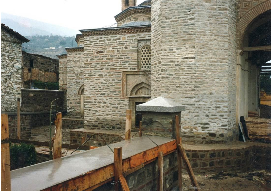
Fotoğraf 15. Çevre Duvarı Yenilenmesi ve Doğu Cephe Boyunca Uzanan Seki Düzenlemesi (Vakıflar Genel Müdürlüğü Arşivi, 2023)
