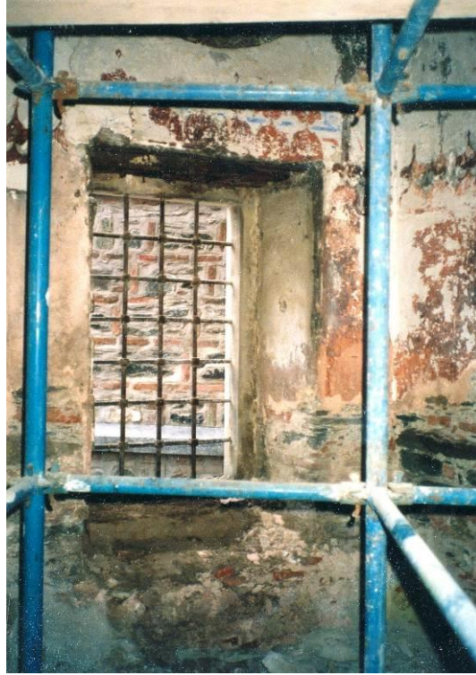
Fotoğraf 22. Nakışların Açığa Çıkarılması (Vakıflar Genel Müdürlüğü Arşivi, 2023)
