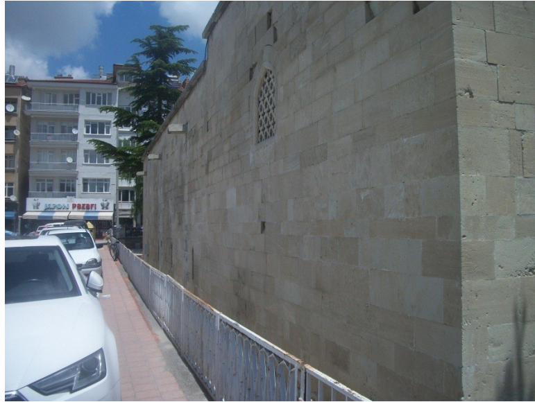
Fotoğraf 6. Batı cephe
