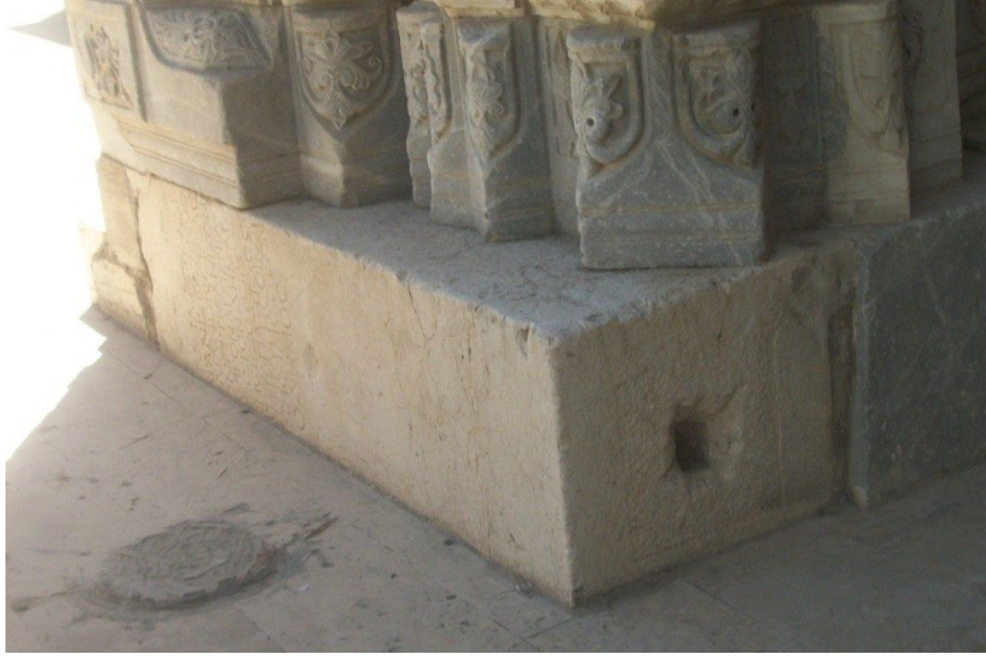
Fotoğraf 23. Kuzey cephe, Taç kapıda kullanılan devşirme malzeme, Ayrıntı
