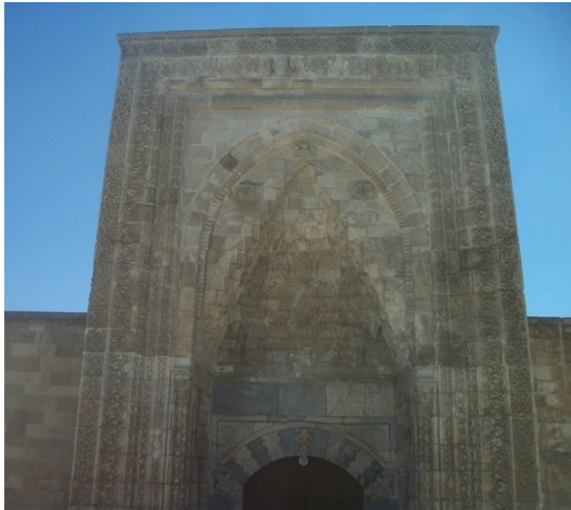
Fotoğraf 26. Medrese, Kuzey cephe, Taç kapı, Genel görünüm
