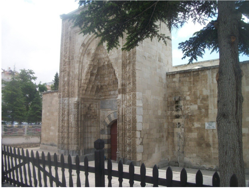
Fotoğraf 4. Kuzey cephe
