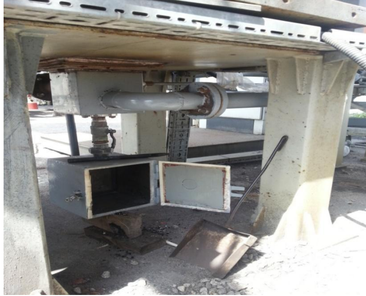
Şekil 3.7. Kül Boşaltma sistemi
