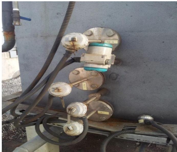
Şekil 3.6. Gazlaştırıcı Bölgesindeki Isıl Çiftler
