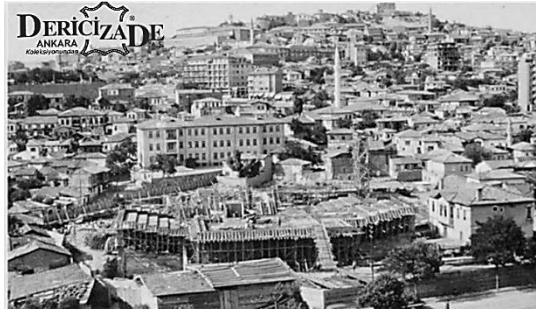
Fotoğraf 31. Çocuk Hastanesi inşaat halinde.
