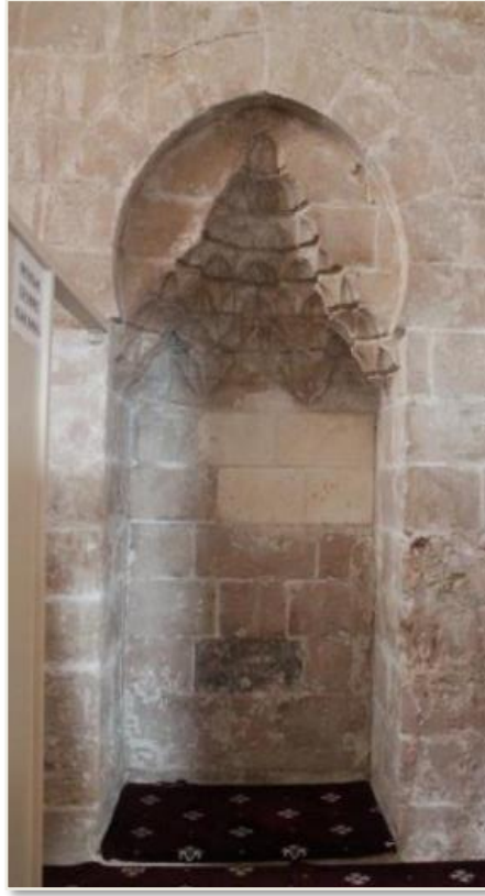
Fotoğraf 40. Kasımiye Medresesi, L Planlı Mekânın Kuzey Duvarının Batısındaki Mukarnas Kavsaralı Dikdörtgen Niş
