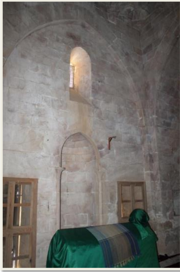
Fotoğraf 48. Türbe Mekânının Güney Kanadı
