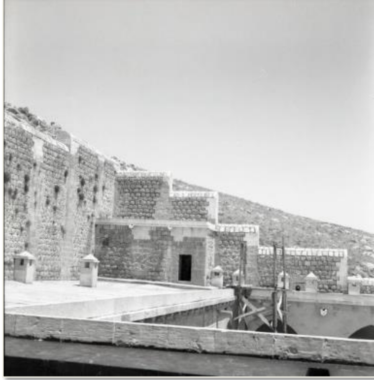
Fotoğraf 26.Kasımiye Medresesi Onarım Sonrası Beton Dam (VGMA)
