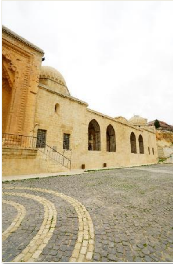
Fotoğraf 34.Kasımiye Medrese 'sinin Güney Cephesinin Doğu Kısmı (Kılıç,2020)
