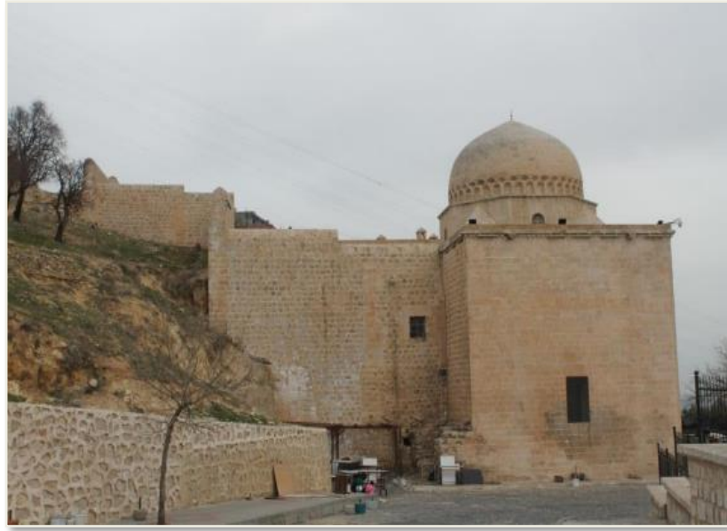
Fotoğraf 35.Kasımiye Medresesi, Batı Cephe Görünüşü
