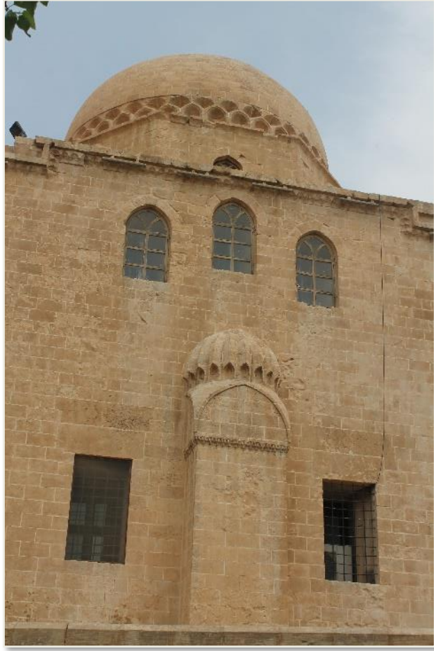
Fotoğraf 68. Güney Cephede Eksenin Batısında Cephenin Orta Bölümünün Yaklaşık Üzerine Kadar Yükselen Dikdörtgen Payanda
