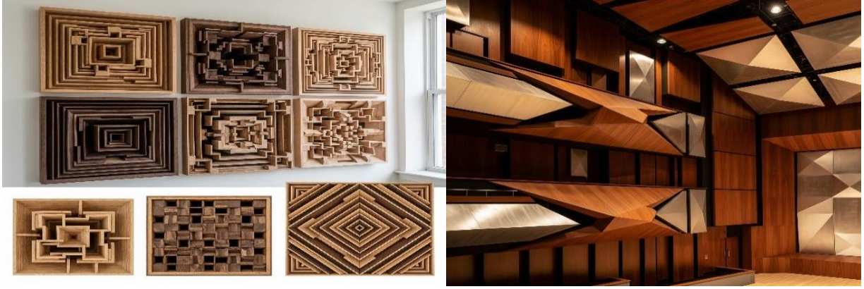
Görsel 38. – Görsel 39. Ses enerjisinin eşit dağılımını sağlayan yüzey difüzörleri (Google Image Generation Model, Google, 2026)
