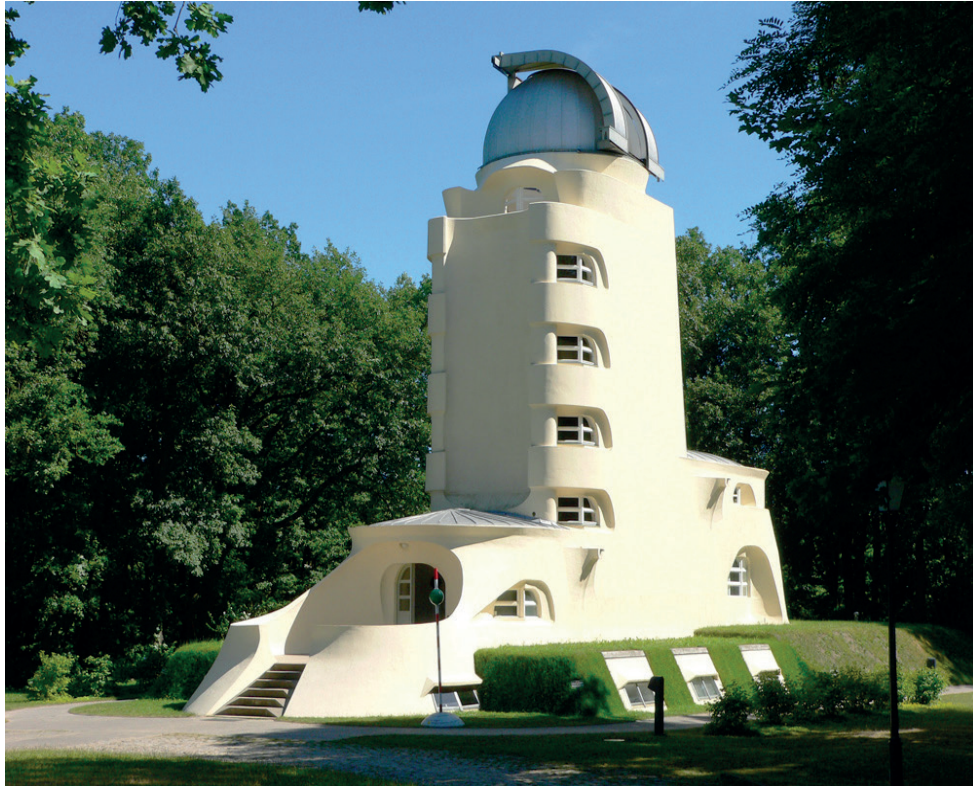
Görsel 5. Erich Mendelsohn, "Einstein Kulesi". 1921. (Tuğla yığma ve betonarme karkas üzerine kireç-çimento sıva). https://www.kisa.link/DAecr
