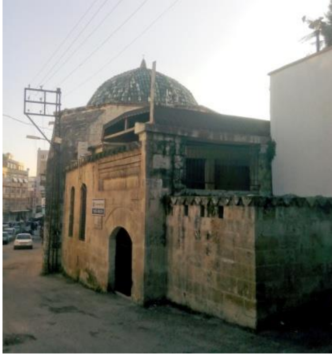
Fotoğraf 208. Kuzeydoğudan genel görünüm
