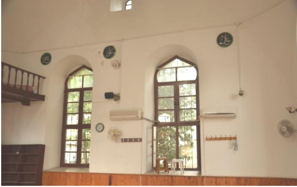
Fotoğraf 157. İçten görünüm, batı duvar
