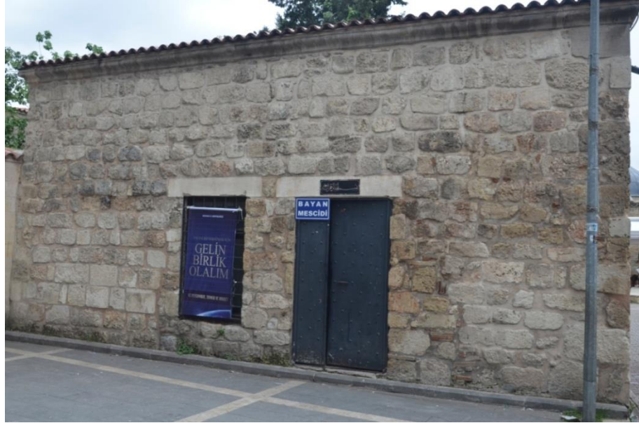
Fotoğraf 105. Kuzey cephe
