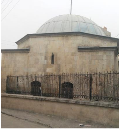
Fotoğraf 199. Batı cephe
