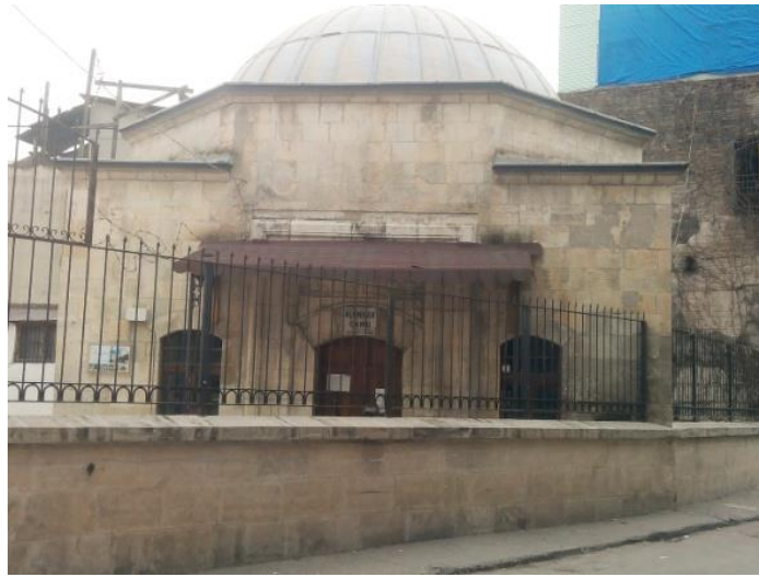
Fotoğraf 197. Kuzey cephe
