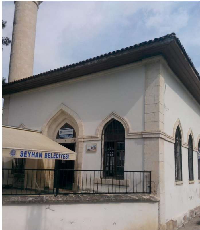
Fotoğraf 291. Kuzeybatı cephe
