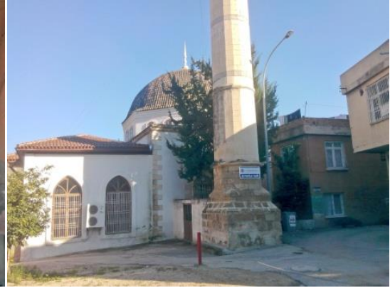
Fotoğraf 244. Batı cephe, genel görünüm
