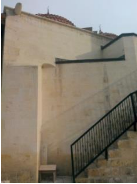
Fotoğraf 168. Batı cephe
