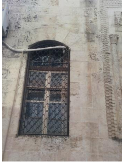
Fotoğraf 214. Doğu cephe pencerelerinden
