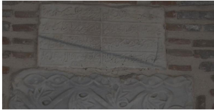
Fotoğraf 285. Şeyh Zülfo Mesciti, onarım kitabesi (M. Can Kızılgıdemir)
