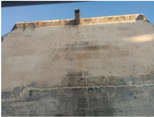
Fotoğraf 221. Batı cephe
