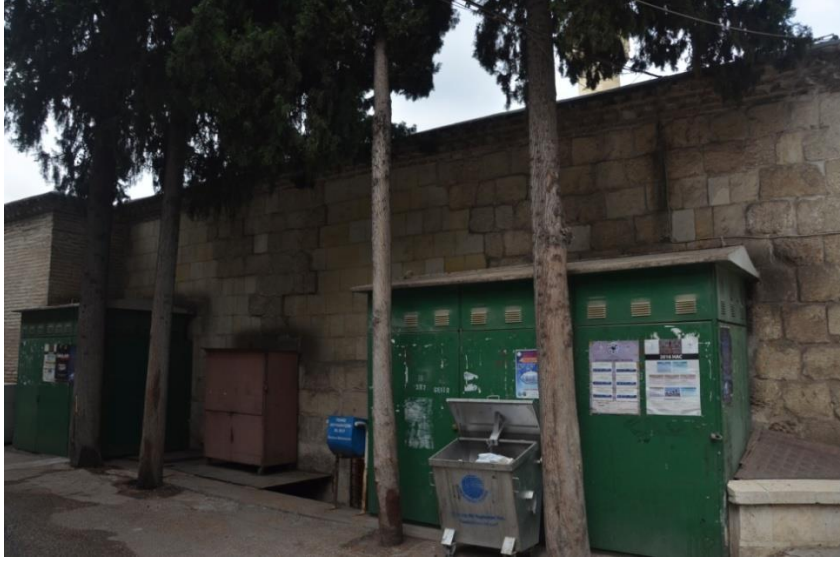
Fotoğraf 7. Batı cephe
