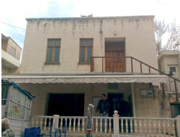
Fotoğraf 262. Kuzey cephe
