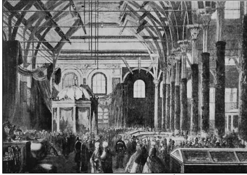
Görsel 75: Sergi-i Umumi-i Osmanî Sergi Binasının İç Görünümü Kaynak: Mir'at , 3 Cemazeyilahir 1279 (26 Kasım 1862), s. 47.
