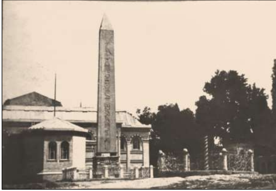
Görsel 76: Sergi-i Umumi-i Osmanî Sergi Binası'nın Güney Cephesi (Daire-i Hümayun ile Birlikte), Yakınındaki Dikilitaş Kaynak: Hippodrom/Atmeydanı, 2010, s. 318.
