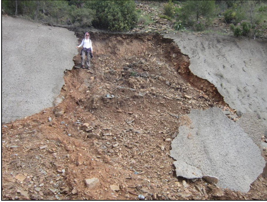
Şekil 5.11. Meydana gelen dökülmeler ve ilk kütle hareketleri sonrası geçici olarak oluşturulan püskürtme beton
