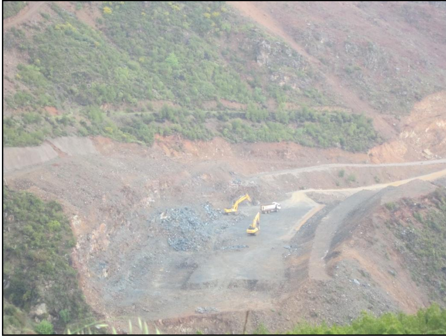
Şekil 4.7. Çalışma alanında gerçekleşen şev inşaatından bir görünüm
