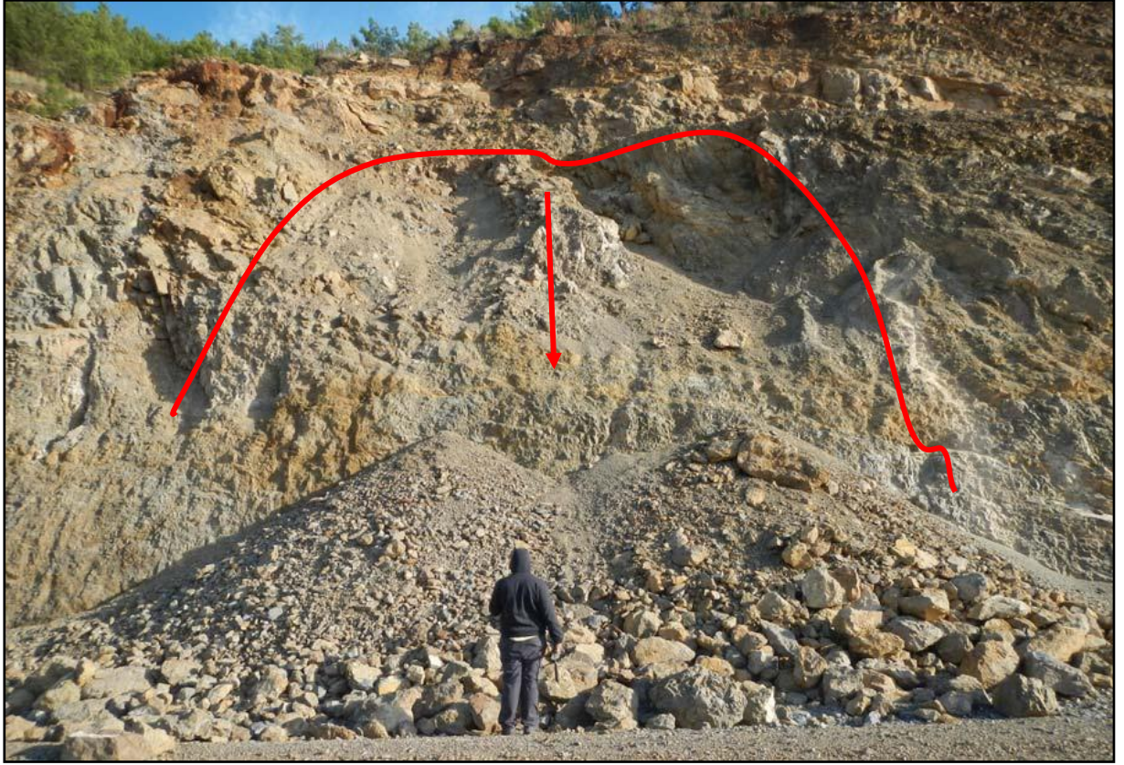
Şekil 6.5. Km: 226+800 kesiminde meydana gelen stabilite problemleri ve geometrik olarak yorumlanması
