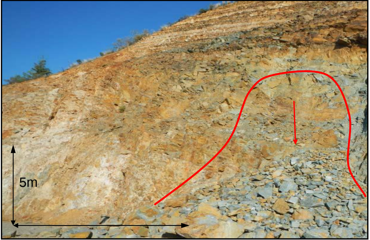
Şekil 6.8. Km: 227+300 kesiminde meydana gelen stabilite problemleri ve geometrik olarak yorumlanması
