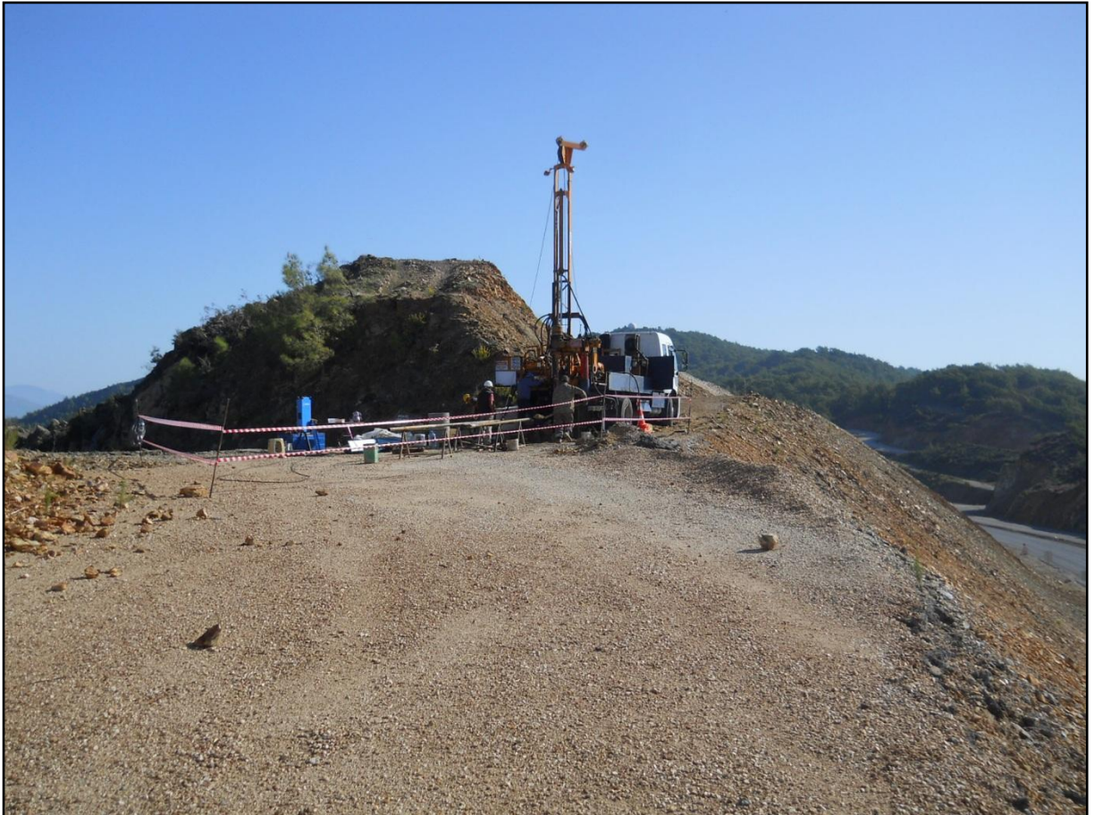
Şekil 5.2. Yüksel Proje firması tarafından, 2012 yılında bölgede gerçekleştirilen temel araştırma sondaj çalışmalarından bir görünüm
