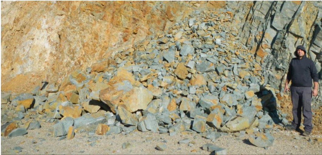
Şekil 5.17. Yarma şevlerinde meydana gelen kütte hareketinden bir görünüm
