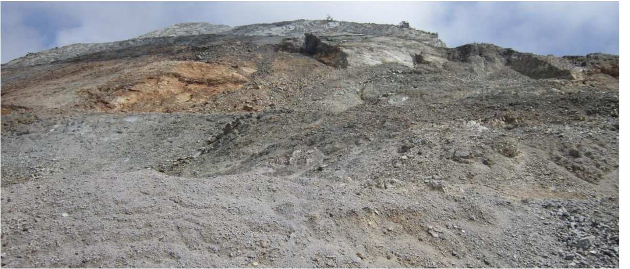
Şekil 5.20. Yarma kesitinde meydana gelen dökülmeler ve bozulmalar
