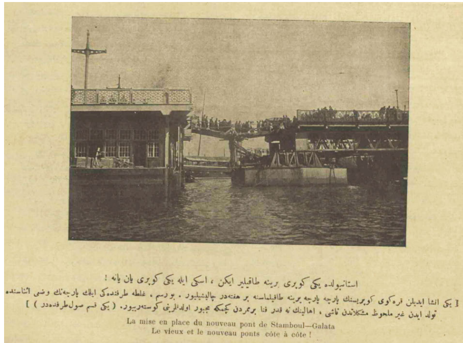
Fotoğraf 352. İstanbul-Galata yeni köprüsünün yapımında eski köprüyle yeni köprü yan yana. Servet-i Fünun, Nisan 1328 (1912)
