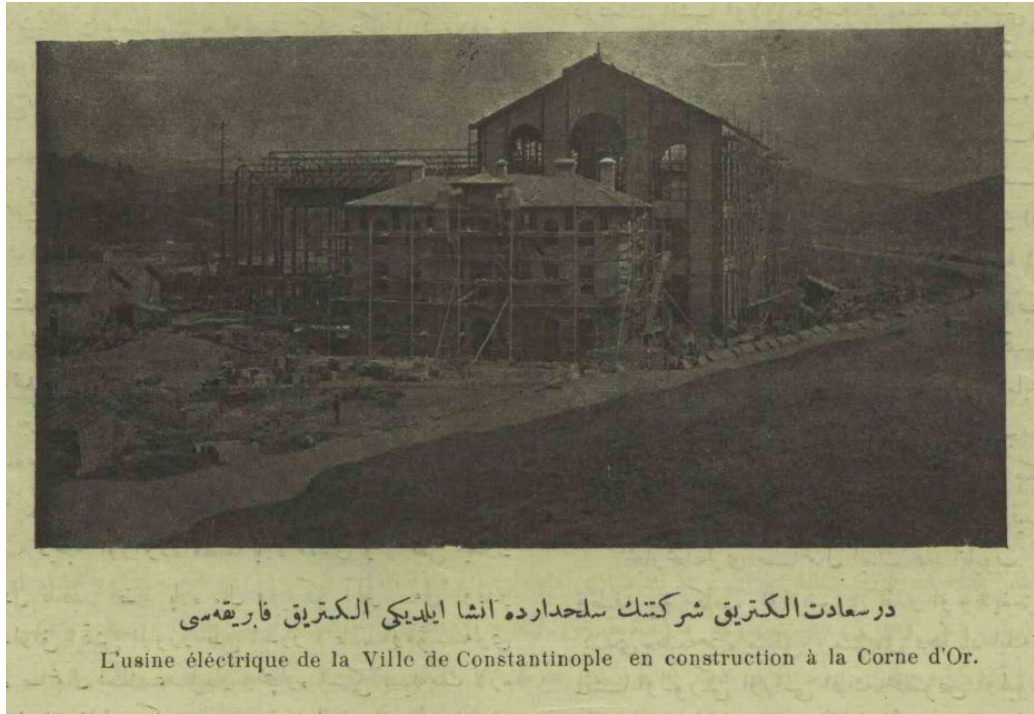
Fotoğraf 338. Dersaadet Elektrik Şirketinin Silahtarağa'da inşa eylediği elektrik fabrikası. Servet-i Fünun, 23 Mayıs 1329 (5 Haz. 1913) Sayı: 1148
