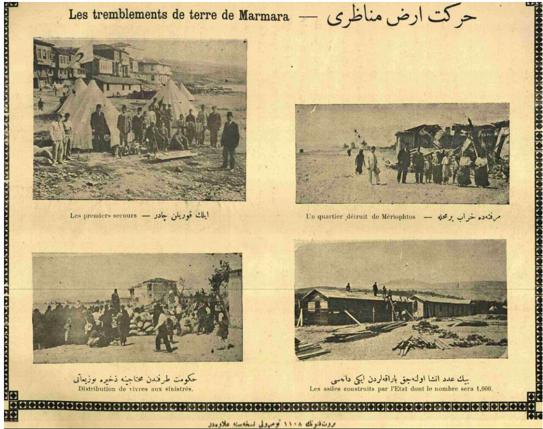
Fotoğraf 309. Saat yönünde. 1-İlk kurulan çadırlar, 2- Mürefte'de harap bir mahalle, 3- Hükümet ihtiyaç sahiplerine dağıtım yapıyor. ,4- İnşa edilecek 1000 adet barakdan ikisi. Servet-i Fünun, 16 Ağustos 1328 (1912) Sayı: 1108
