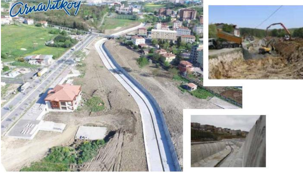
Şekil 4.35. Arnavutköy özelinde 2012-2019 yılları arasında yapılan dere ıslah çalışmaları görüntüleri.
