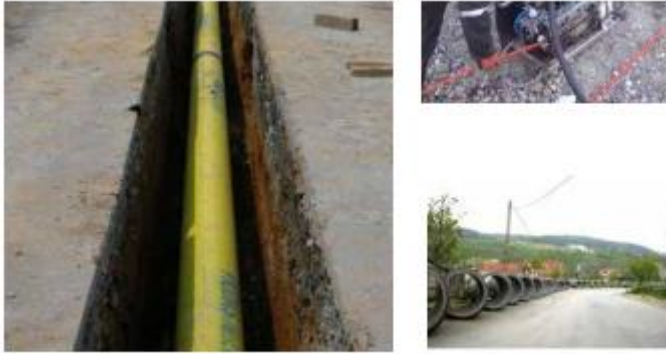
Şekil 4.34. Arnavutköy özelinde 2009-2019 yılları arasında yapılan alt yapı çalışmalarının görüntüleri.
