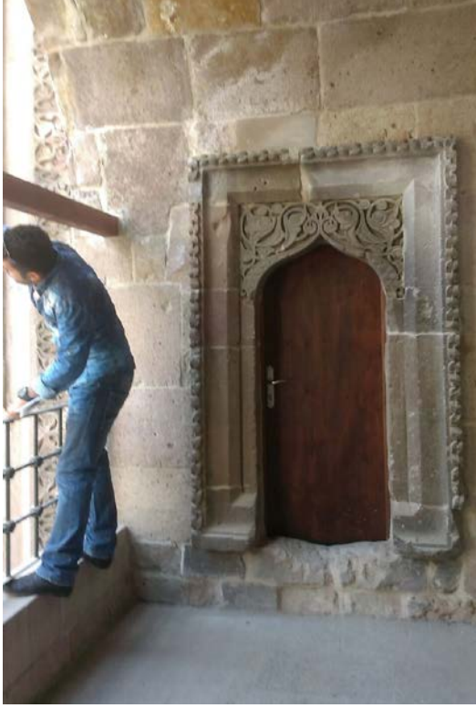
Fotoğraf 27. Medrese, avlu üst kat çatıya çıkış kapısı ayrıntı,
