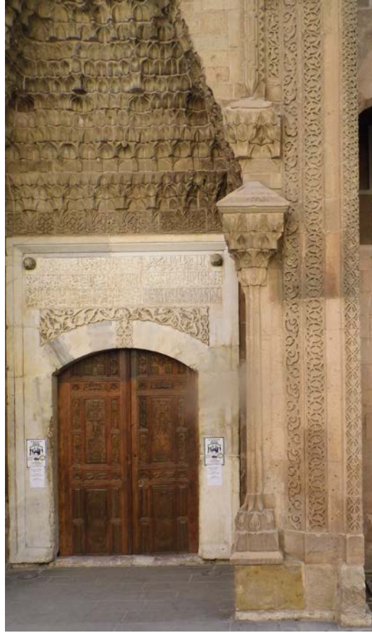
Fotoğraf 34. Medrese, kuzey cephe, taç kapı genel görünüm.
