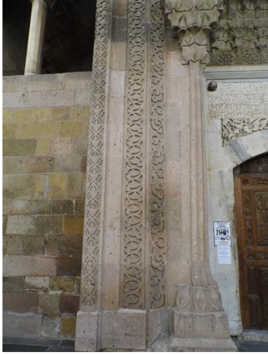
Fotoğraf 33. Medrese, kuzey cephe, taç kapı genel görünüm.
