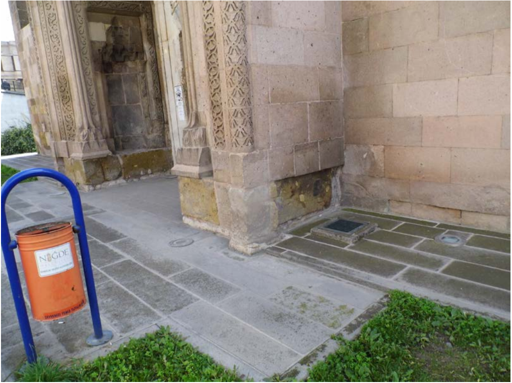
Fotoğraf 31. Kuzey cephe, taç kapıda kullanılan devşirme malzeme, ayrıntı.
