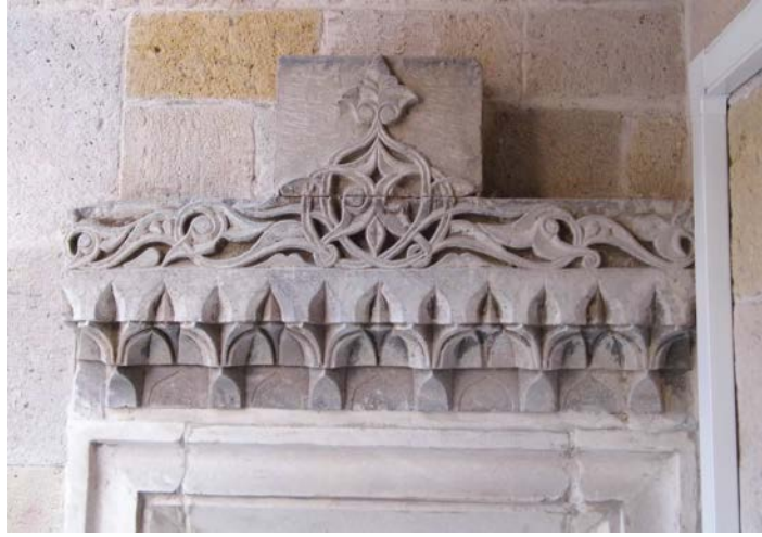
Fotoğraf 51. Ana eyvan bitiřiđi, gneybatı derslane kapısı, ayrıntı
