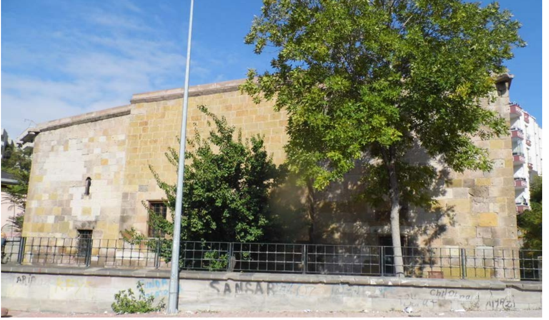
Fotoğraf 13. Medrese güney cephe.
