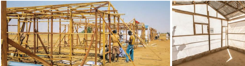
Görsel 56. Acil durum barınaklarının inşası (Global Shelter Cluster, 2017a, s.77)
