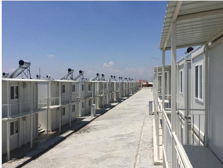
Görsel 86. Geçici konutların güneş enerji sistemi panelleri (MFA İnşaat, 2019)
