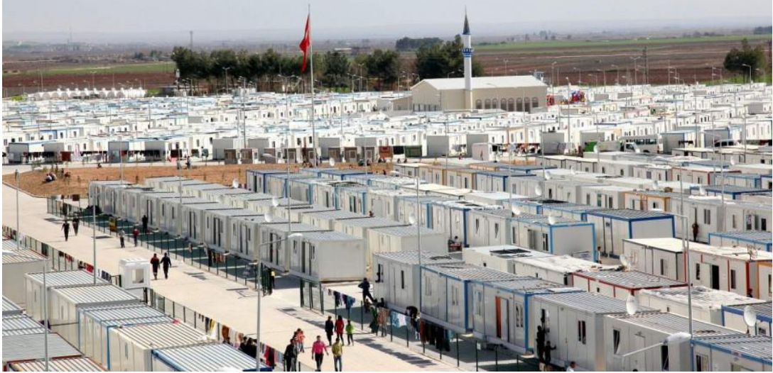
Görsel 45. Harran Konteyner Kent Konaklama Tesisi (URL-17)
