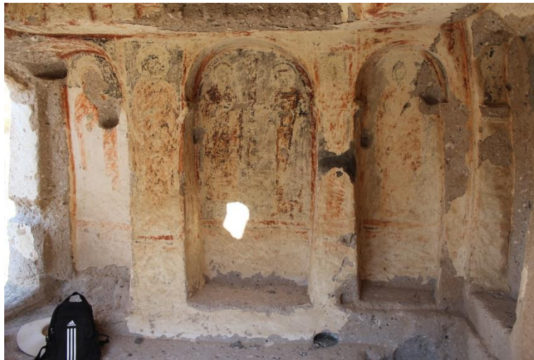
resim 127. Kubbeli III Kilise, batı duvar, solda kilisenin orijinal girişine ait kapı
