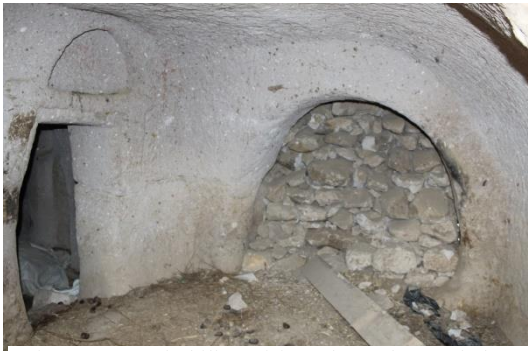
resim 97. 30 no.lu kilise, giriş mekanı, doğuya bakış
