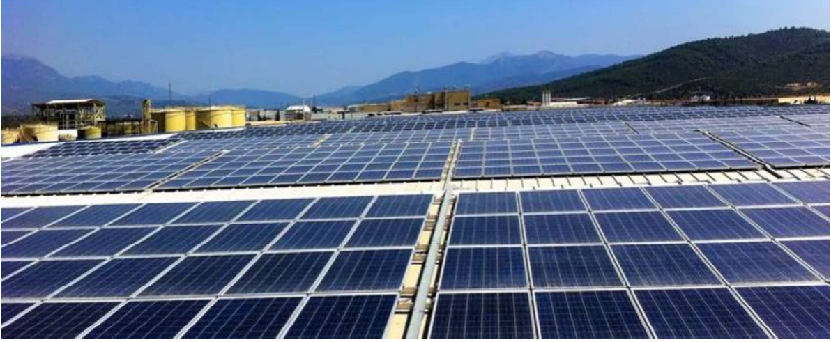
Şekil 3.2: Torbalı GES çatı görünümü
