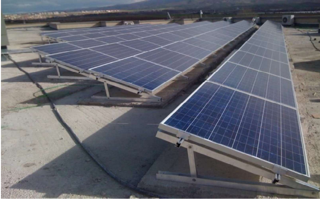
Şekil 3.25: Gölbaşı GES Çatı 1 Bölümü
