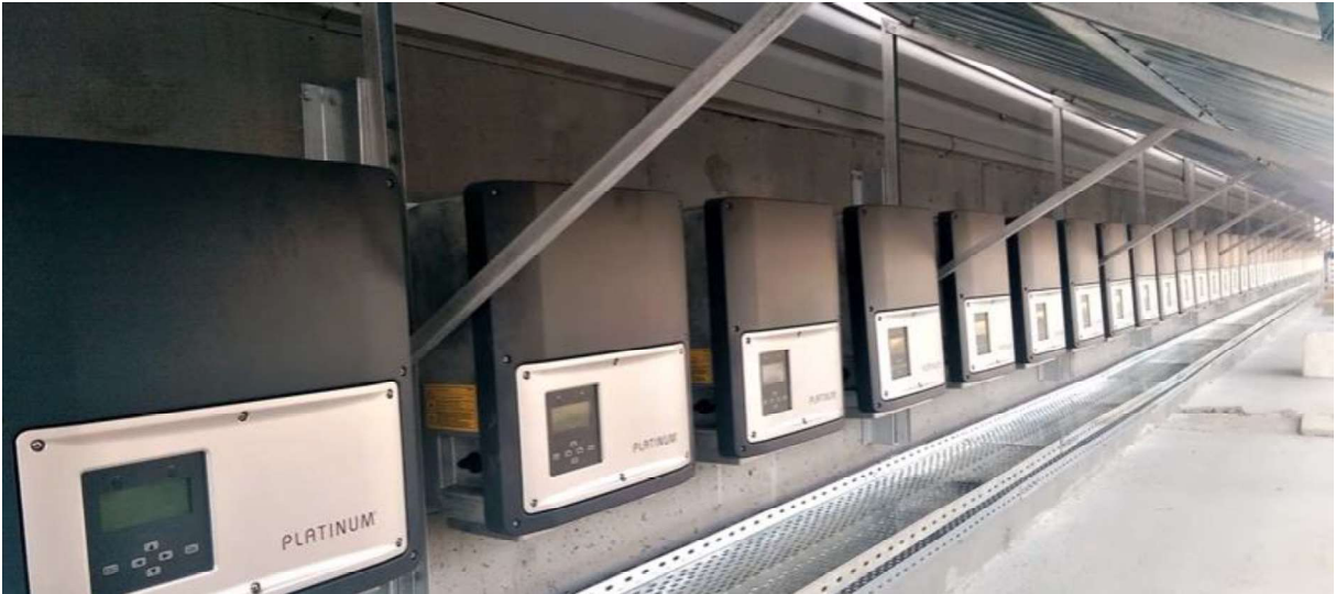
Şekil 3.3: 38 adet Platinum Marka Solar Evirici
