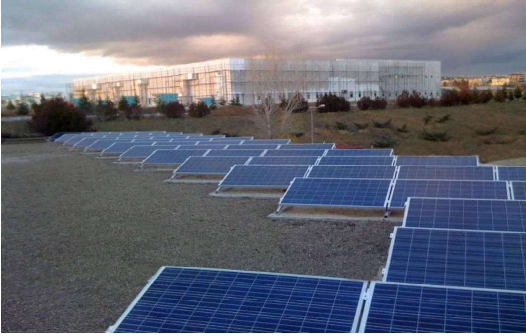
Şekil 3.26: Gölbaşı GES Çatı 2 Bölümü
