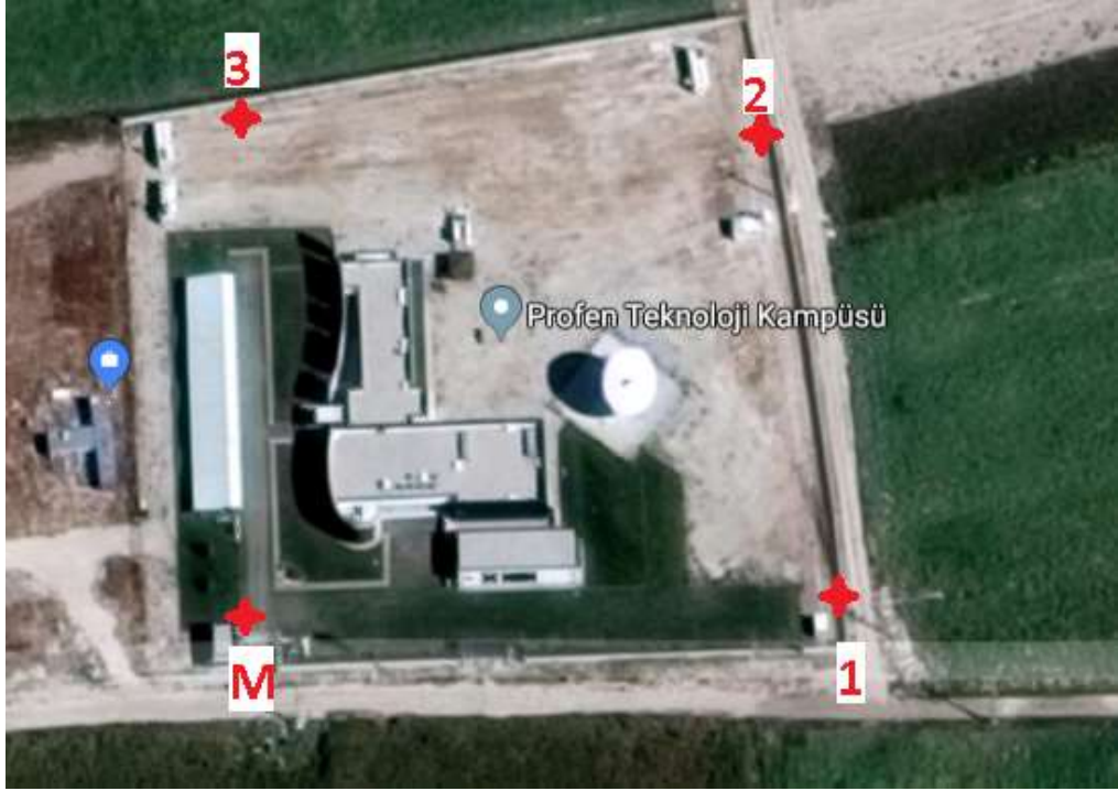
Şekil 4.6. Konya açık alan test sahası.
