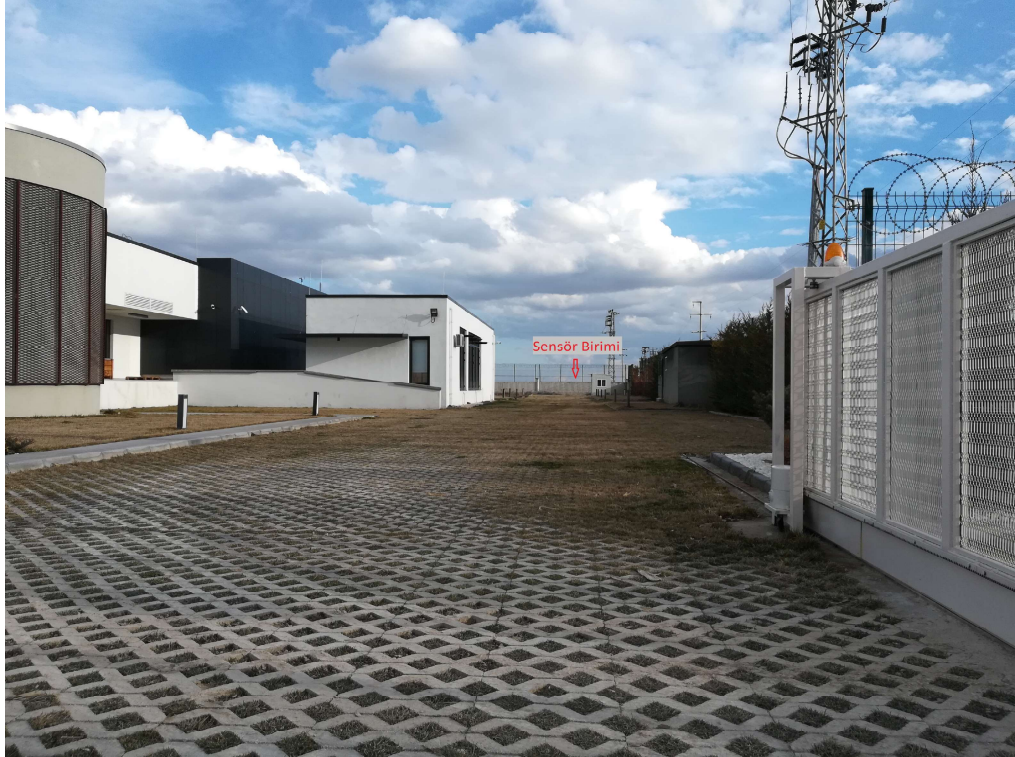
Şekil 4.7. Konya açık alan test sahası.
