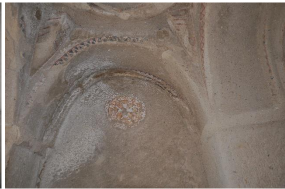
Resim 392. Kilise 4, kubbe geçişleri ve tonoz aynalığı
