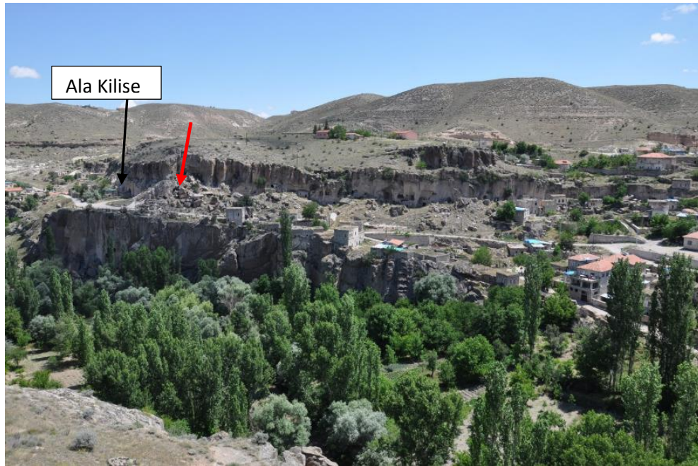
Resim 375. Küçük Ala Kilise, konum, kuzeydoğuya bakış
