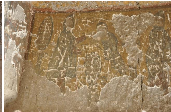
Resim 407. Yılanlı Kilise, portiko güney duvarı
