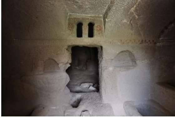
Resim 29. Kilise 3, narteks, doğu duvar
