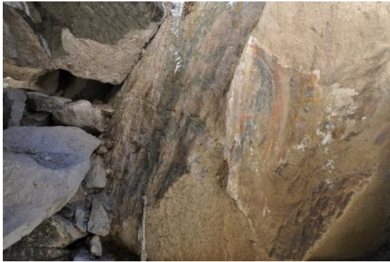
Resim 187. Giriş mekanındaki duvar resmi kalıntısı
