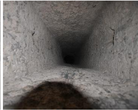
Resim 587. KOM 11, üst katlara çıkış sağlayan tünel
