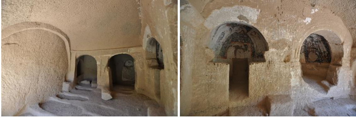
Resim 311. Ballı Kilise, güney nef, kuzeye bakış Resim 312. Ballı Kilise, güney nef, doğuya bakış
