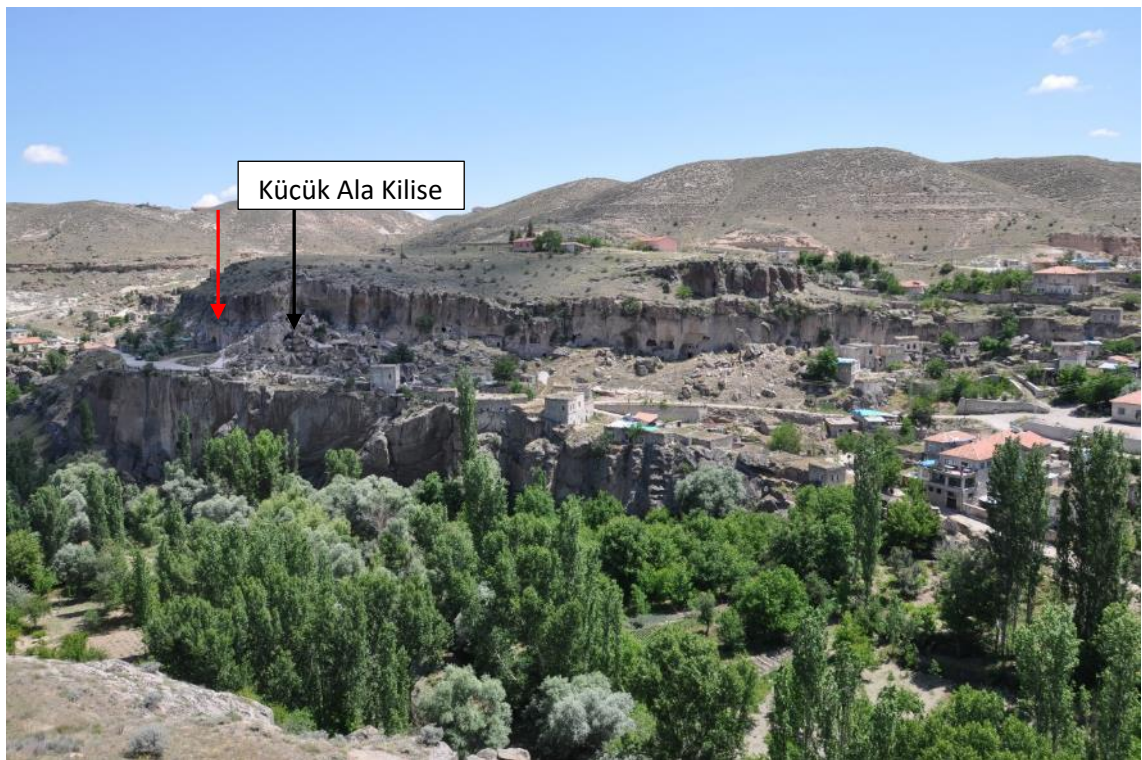
Resim 453. Ala Kilise, konum, kuzeydoğuya bakış
