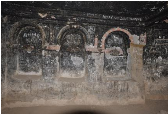
Resim 580. KOM 8, Mekan 1, batı duvarda yuvarlak kemerli nişler
