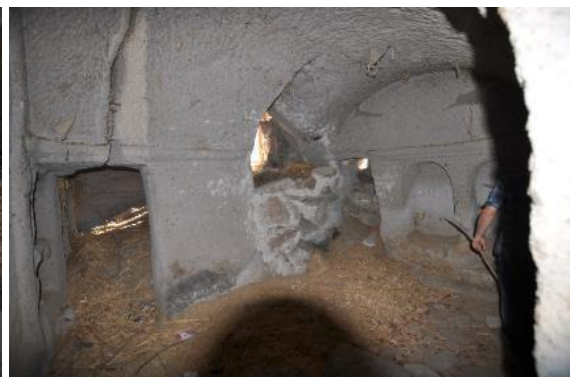
Resim 286. Kilise 2, kuzey nef, güneybatıya bakış
