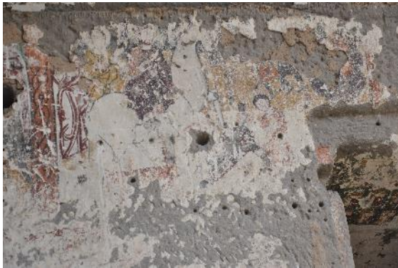
Resim 170. Eğri Taş Kilisesi, güney duvar ayrıntı
