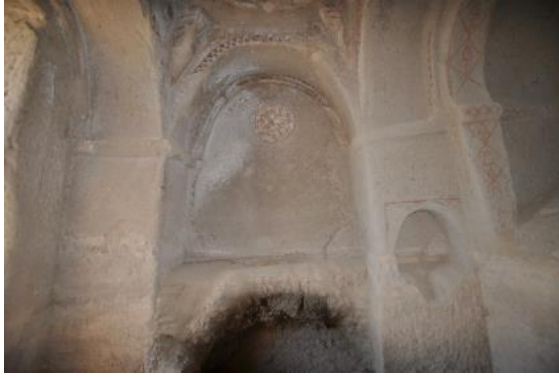
Resim 389. Kilise 4, naos, kuzey duvar
