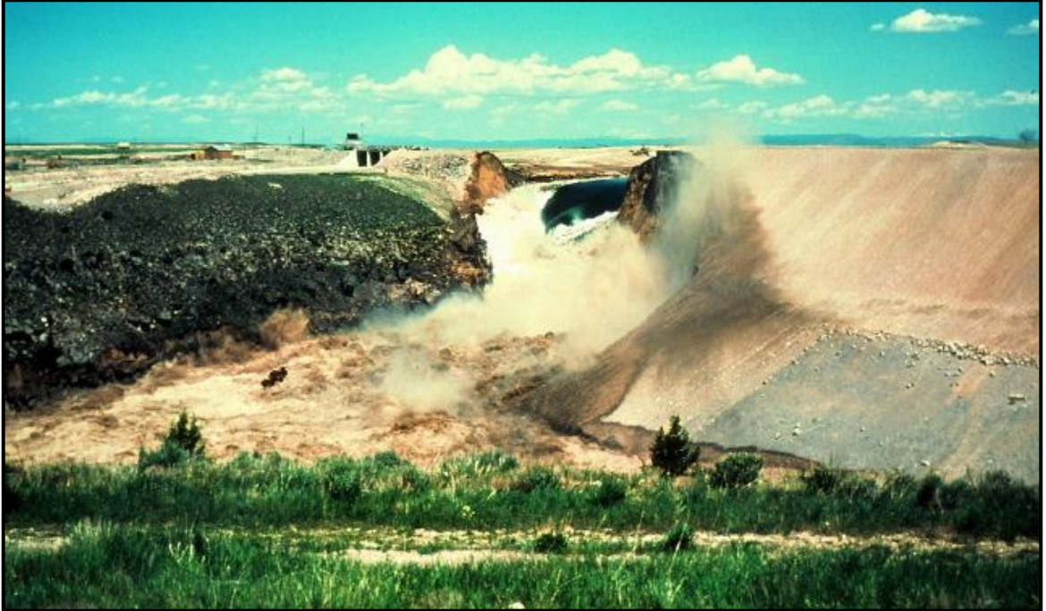
Şekil 4.3 Teton Barajı'nın (ABD) yıkılması [79].
