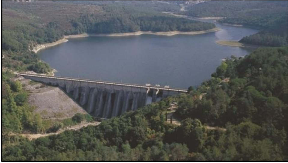
Şekil 3.20 Beton payandalı baraj örneği, İstanbul-Elmalı Barajı [72].
