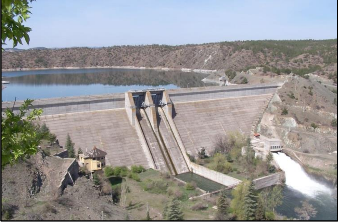
Şekil 3.16 Beton ağırlık baraj örneği, Eskişehir Porsuk Barajı [67].
