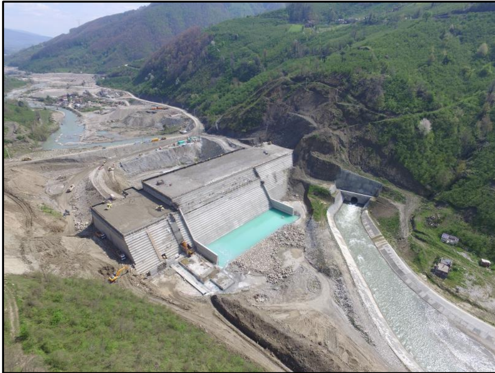
Şekil 3.18 Silindirle sıkıştırılmış beton baraj örneği, Sakarya Ballıkaya Barajı [70].
