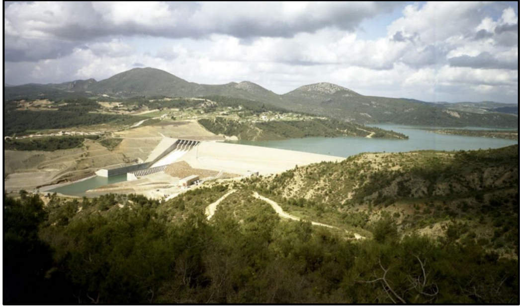
Şekil 3.4 Ülkemizdeki en yüksek homojen dolgu barajlardan Osmaniye Aslantaş Barajı'ndan bir görünüm [55].
