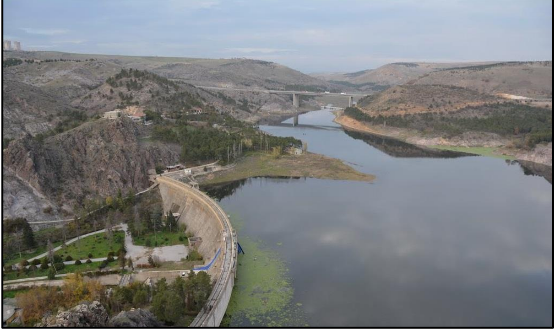
Şekil 3.2 Ankara Çubuk-I Barajı'ndan bir görünüm [51].
