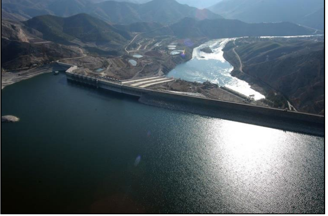
Şekil 3.7 Ülkemizin en yüksek kaya dolgu baraj, Elazığ Keban Barajı [59].
