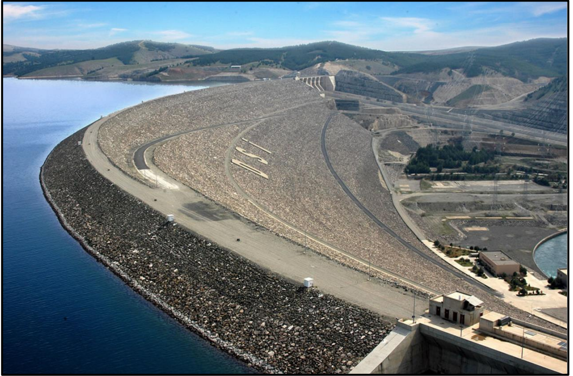
Şekil 3.8 Kil çekirdekli kaya dolgu baraj, Atatürk Barajı [60].
