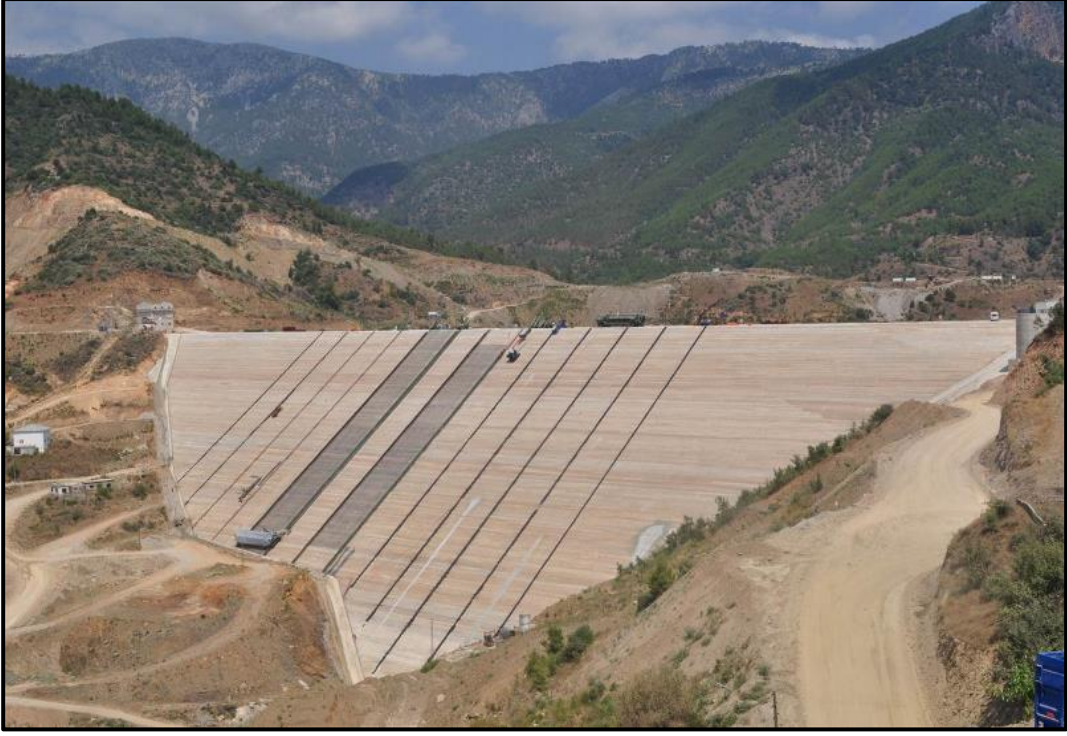
Şekil 3.11 Ön yüzü beton kaplı kaya dolgu, Mersin-Anamur Alaköprü Barajı [62].
