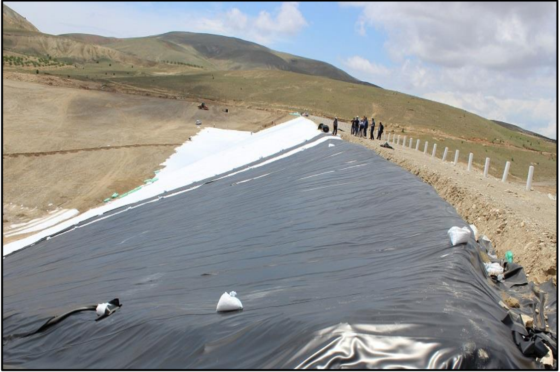
Şekil 3.15 Ön yüzü membran kaplı baraj örneği, Elazığ İçlikaval Göleti [65].
