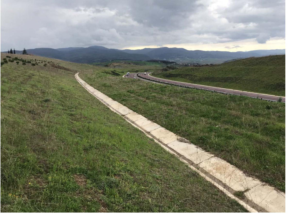
Şekil 9-34 Kabaklı heyelan sahasında oluşturulan şevlerdeki kafa hendekleri
