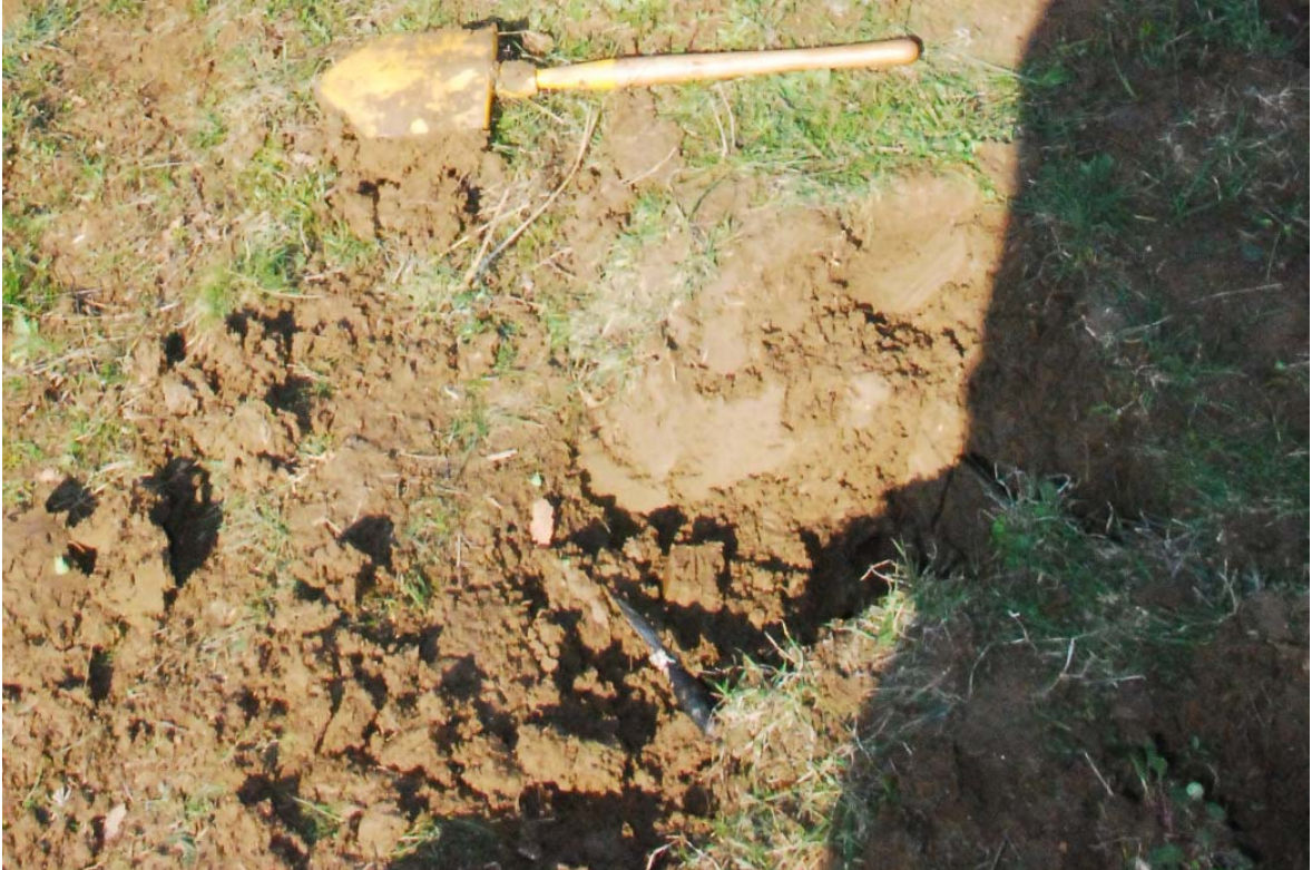
Şekil 7-1. Makaslama örneği alınması için araştırma çukurunun açılması
