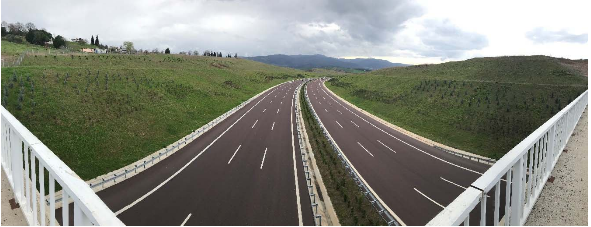
Şekil 9-33 Otoyol projesi kapsamında Kabaklı heyelan sahasında oluşturulan şevlerin panoramik görünümü
