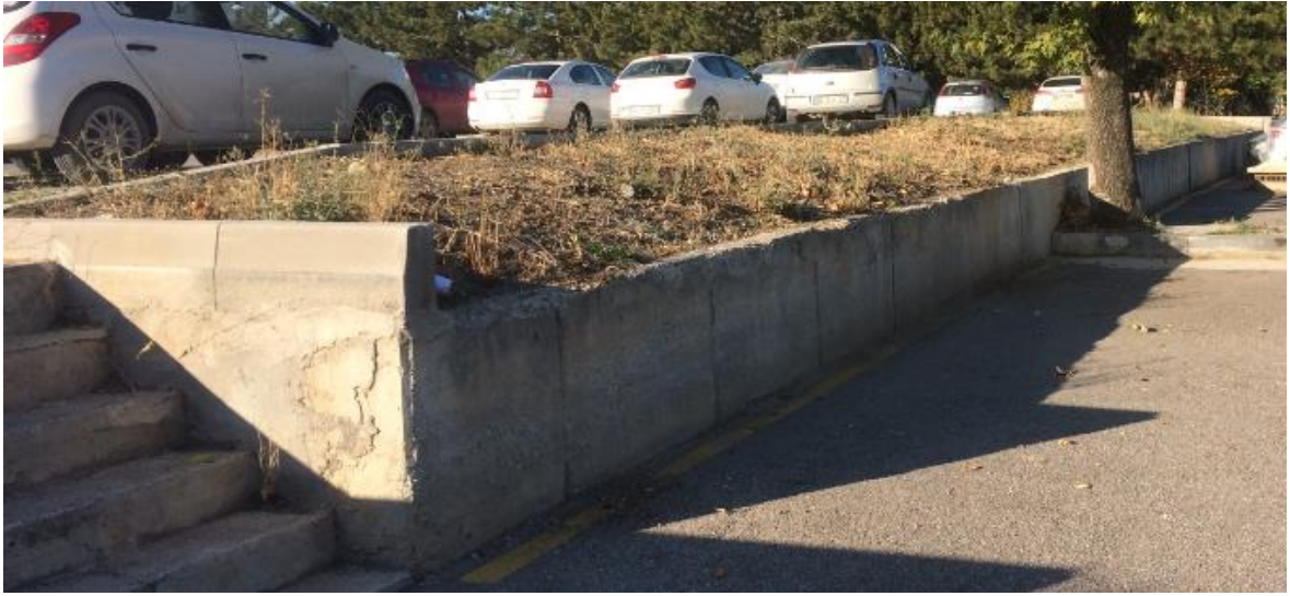
Şekil 4.7. Test alanı #1 içinde yer alan yüksek istinat duvarı
