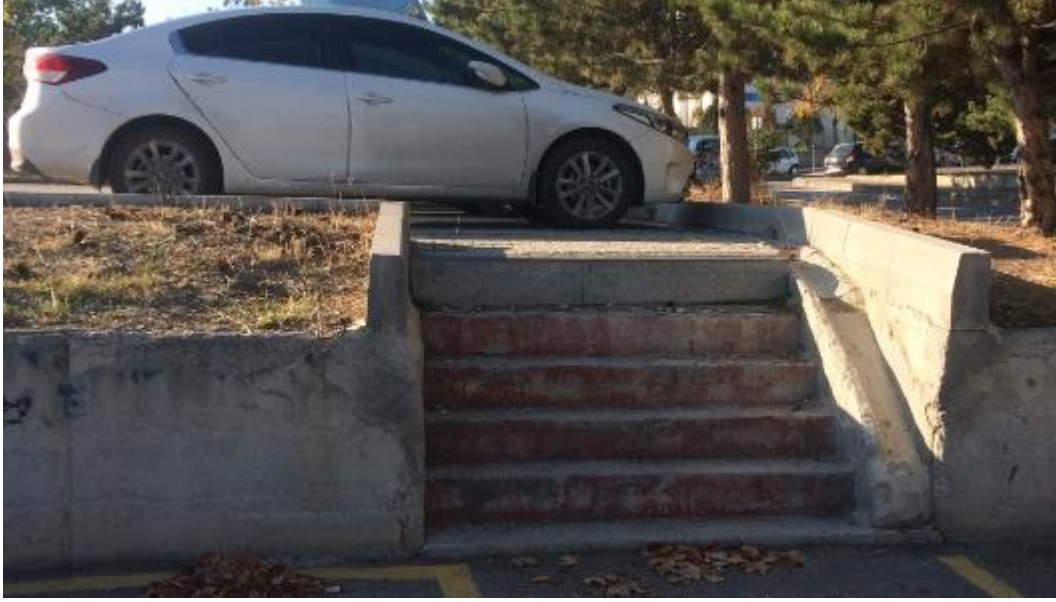
Şekil 4.6. Test alanı #1 içinde yer alan merdiven alanı
