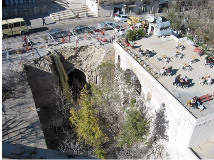
Şekil 22: Şehidiye Camii Restorasyon Öncesi Avlu, Üst Örtüsü ve Yol. İletmiş. (2011).
