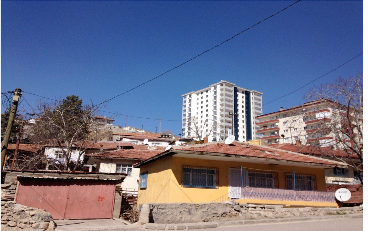
Gecekondu Sırtlarında Binalar Yükselirken
