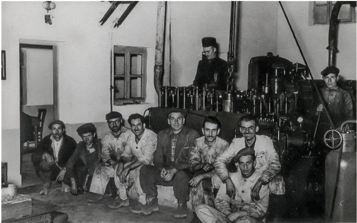
Görsel 20: Değirmisaz elektrik santralinde çalışan işçiler. Yıl belirsiz. 171
