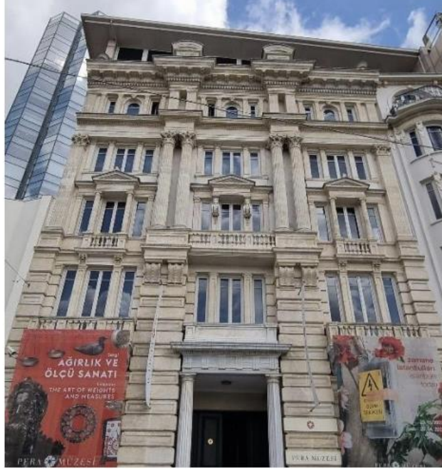
Görsel 21. Pera Müzesi'nin Dış Cephe Görünümü,
