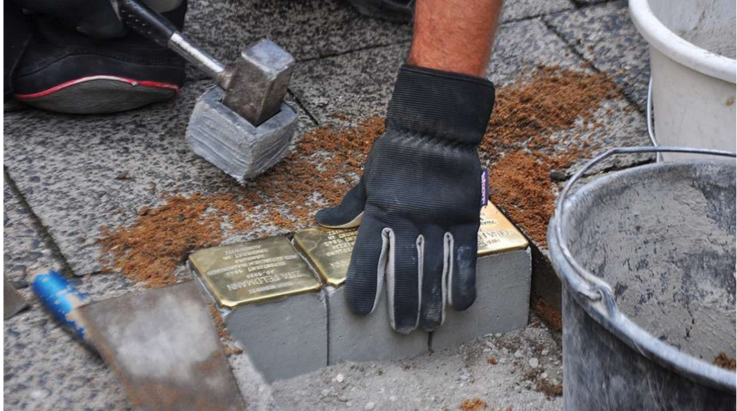
GÖRSEL 41: Tökezleten Taşların Kaldırma Eklenmesi 44
