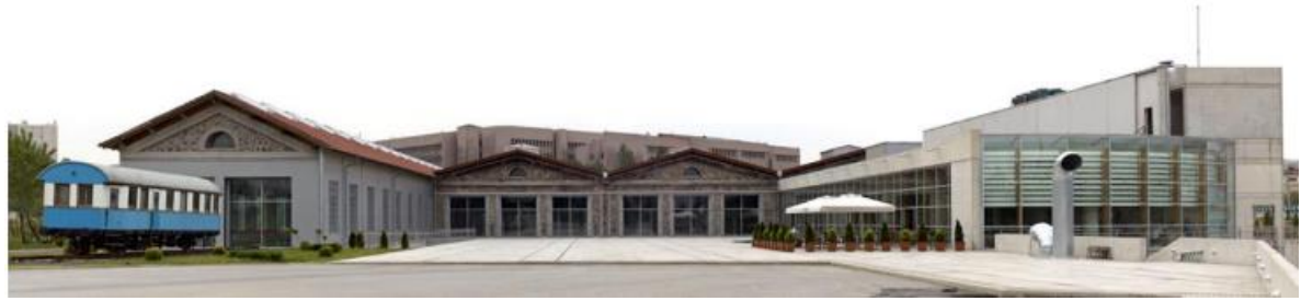
Görsel 37. Avludan yeniden işlevlendirme sonrası görünüm.
