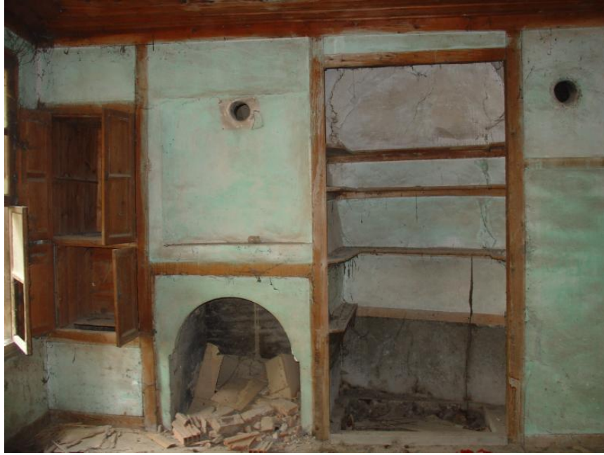
Görsel 81. Gaydarođlu Konađı Sanat Merkezi, 1-06 oda bölümünün güney cephesinde bulunan restorasyon öncesindeki gömme dolap, ocak ve depolama alanı. Necmettin Eryılmaz fotoğraf arşivi.
