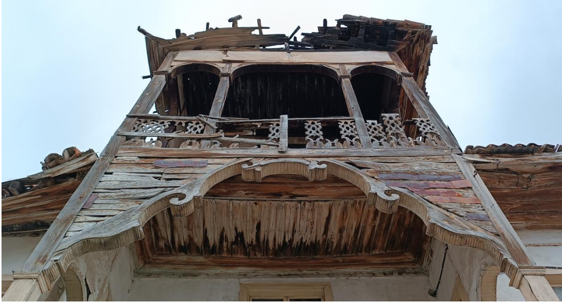
Görsel 44. C ve S şeklinde bağdadi tekniği ile yapılmış olan cumba saçakları ve cumba cephesi. Cımbılların Konağı. Zile, Amasya Caddesi. 13 Ada, 1 Parsel. Aybike Nur Kılıçgil fotoğraf arşivi. 2022.
