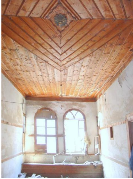
Görsel 83. Gaydarođlu Konađı Sanat Merkezi, 1-02 oda bölümünün batı cephesinde bulunan restorasyon öncesindeki cumba ve ahşap kemerli pencereleri. Necmettin Eryılmaz fotoğraf arşivi.
