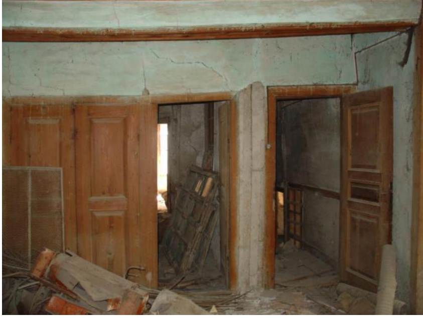
Görsel 66. Gaydaroğlu Konağı Sanat Merkezi, Z-06 oda bölümününün batı cephesinde bulunan restorasyon öncesindeki gömme dolap ve kapılar. Necmettin Eryılmaz fotoğraf arşivi.
