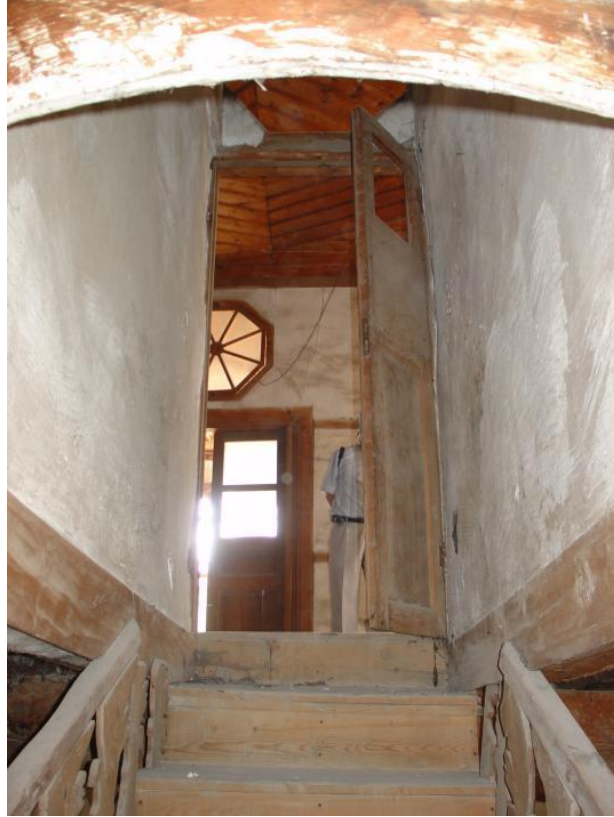
Görsel 75. Gaydarođlu Konađı Sanat Merkezi, Z-04 hayat bölümünün güneydođu kısmında bulunan restorasyon öncesindeki U planlı ahşap merdiven. Necmettin Eryılmaz fotoğraf arşivi.
