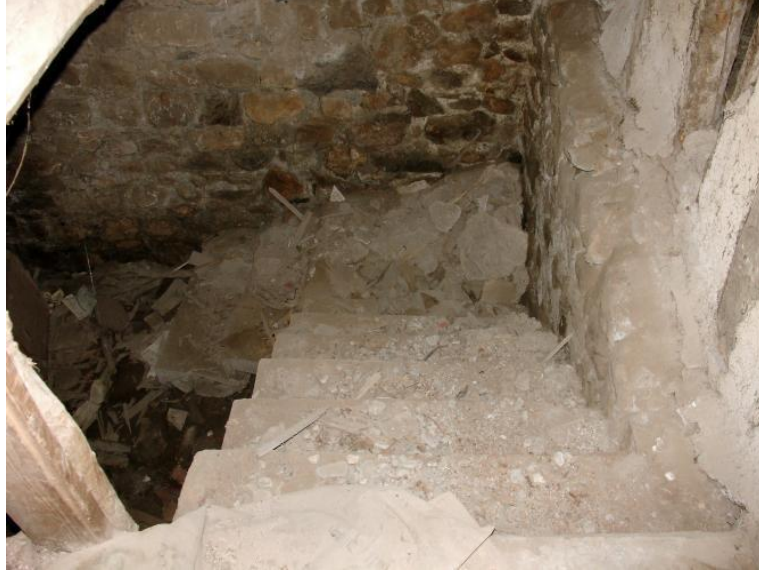
Görsel 69. Gaydarođlu Konađı Sanat Merkezi, B-01 bodrum katı bölümüne inilen restorasyon öncesindeki yıđma tař ile yapılmıř merdiven bölümü. Necmettin Eryılmaz fotoğraf arřivi.
