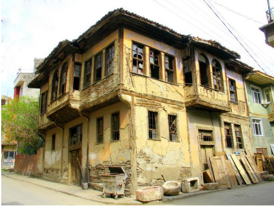
Görsel 91. Gaydaroğlu Konağı Sanat Merkezi, restorasyon öncesindeki cephe tahribatları. Necmettin Eryılmaz fotoğraf arşivi.
