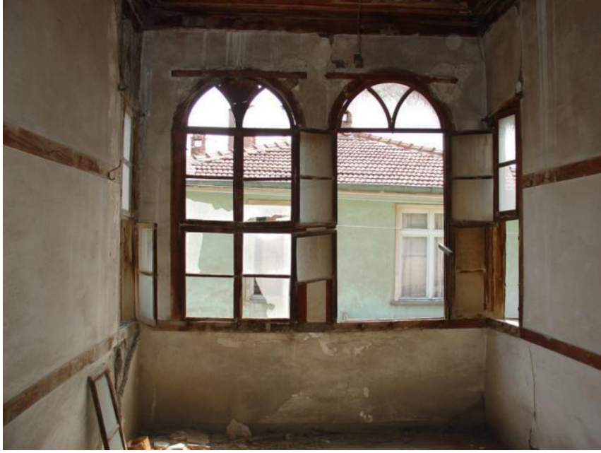
Görsel 78. Gaydaroğlu Konağı Sanat Merkezi, 1-04 sofa bölümünün kuzey cephesinde bulunan restorasyon öncesindeki ahşap kemerli pencereler. Necmettin Eryılmaz fotoğraf arşivi.
