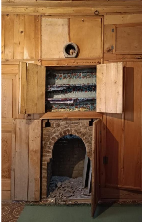
Görsel 47. Odalarda bulunan gömme dolap içerisinde yer alan tuğla ile yapılmış ocak. Zile, Perihan Özkaleli'nin evi. 38 Ada, 73 Parsel. Aybike Nur Kılıçgil fotoğraf arşivi. 2022.
