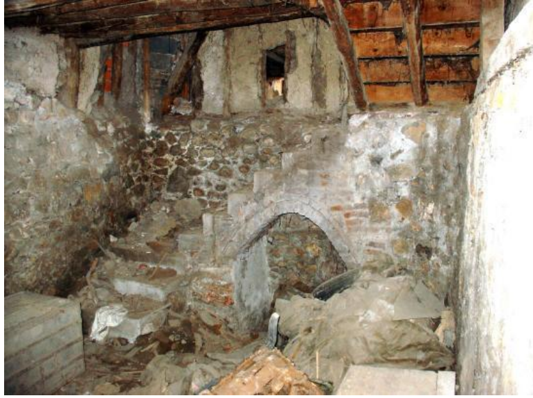
Görsel 70. Gaydarođlu Konađı Sanat Merkezi, B-01 bodrum katı bölümünün batı cephesinde bulunan restorasyon öncesindeki tuđla ile yapılmıř ocak bölümü. Necmettin Eryılmaz fotoğraf arřivi.
