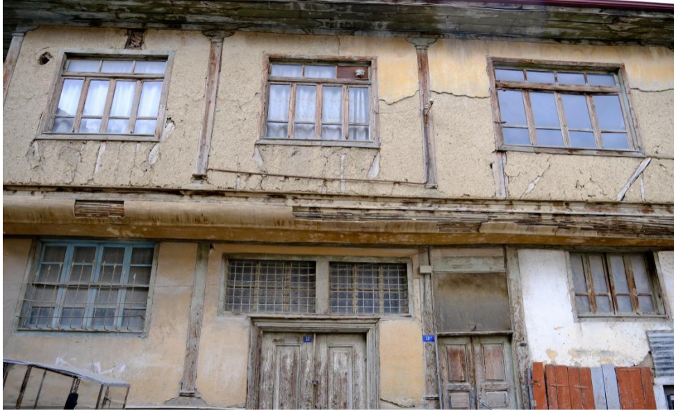
Görsel 43. Bağdadi tekniği ile yapılmış kat silmesi ve kerpiç dolgu. Zile, Faruk Demirtola Konağı. Nurhan Buhan fotoğraf arşivi. 2022.
