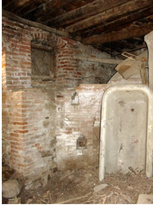
Görsel 68. Gaydarođlu Konađı Sanat Merkezi, B-01 bodrum katı bölümünün dođu cephesinde bulunan restorasyon öncesindeki tuđla ile yapılmıř kapaklı fırın ve ocak bölümü. Necmettin Eryılmaz fotoğraf arřivi.
