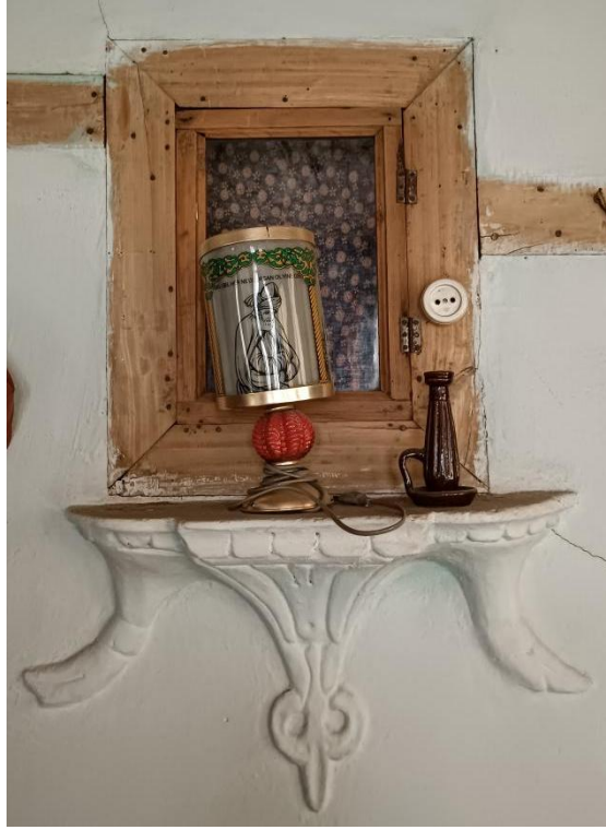
Görsel 50. Alçı ile yapılmış raf sistemli parsu örneği. Münadiye Özerol'un evi. Zile, Gazneli Sokak. 38 Ada, 76 Parsel. Aybike Nur Kılıçgil fotoğraf arşivi. 2022.
