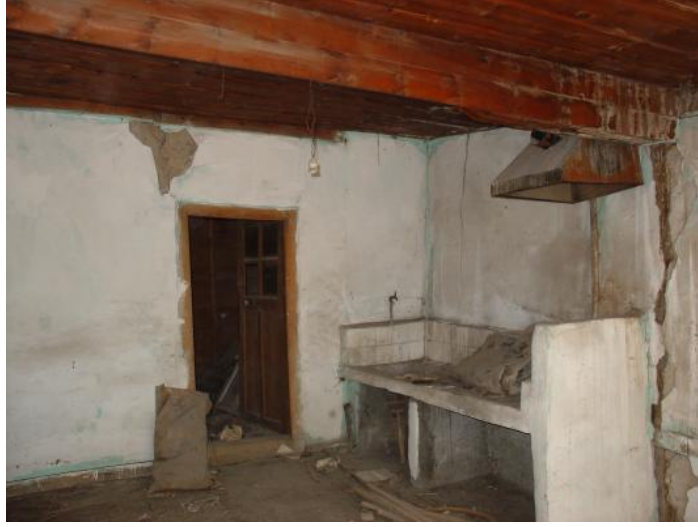
Görsel 71. Gaydaroğlu Konağı Sanat Merkezi, Z-01 oda bölümünün güney cephesinde bulunan sonradan eklenmiş restorasyon öncesindeki tezgâh ve davlumbaz. Necmettin Eryılmaz fotoğraf arşivi.
