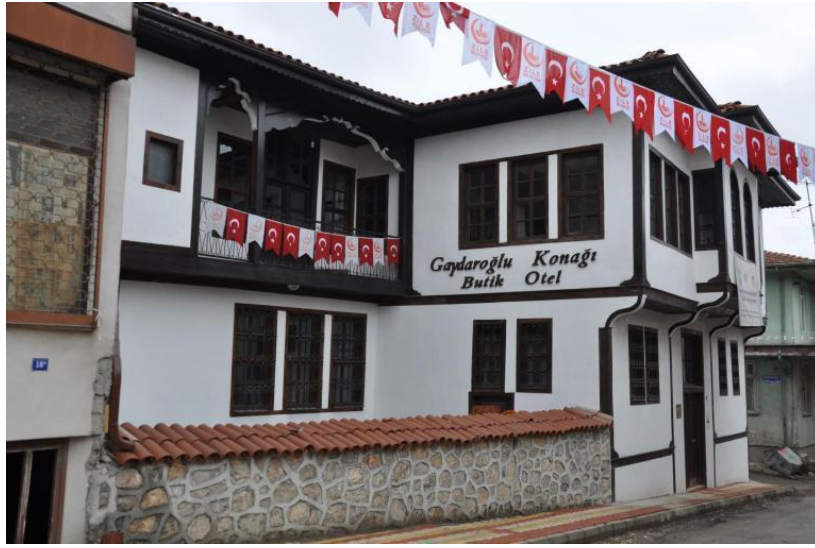
Görsel 92. Gaydaroğlu Konağı Butik Oteli restorasyonu sonrası cephe görünümü.
