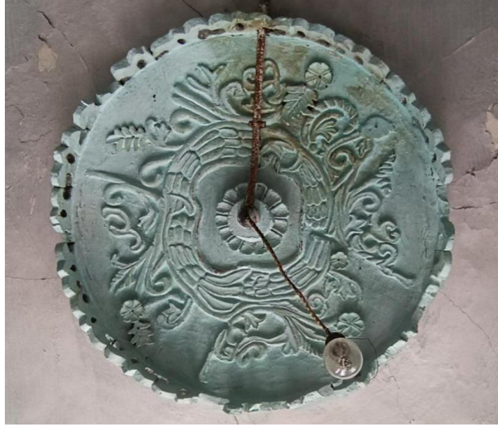
Görsel 49. Malakari tekniği ile yapılmış tavan göbeği örneği. Münadiye Özerol'un evi. Zile, Gazneli Sokak. 38 Ada, 76 Parsel. Aybike Nur Kılıçgil fotoğraf arşivi. 2022.
