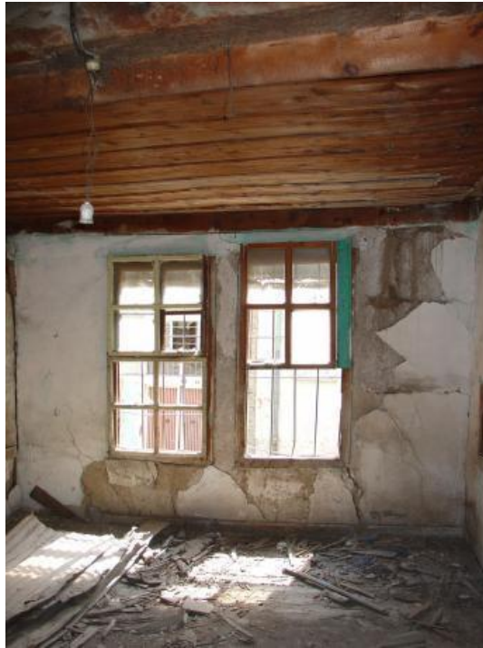
Görsel 72. Gaydaroğlu Konağı Sanat Merkezi, Z-01 oda bölümünün güney cephesinde bulunan ½ oranında yapılmış, restorasyon öncesindeki ahşap pencereler. Necmettin Eryılmaz fotoğraf arşivi.
