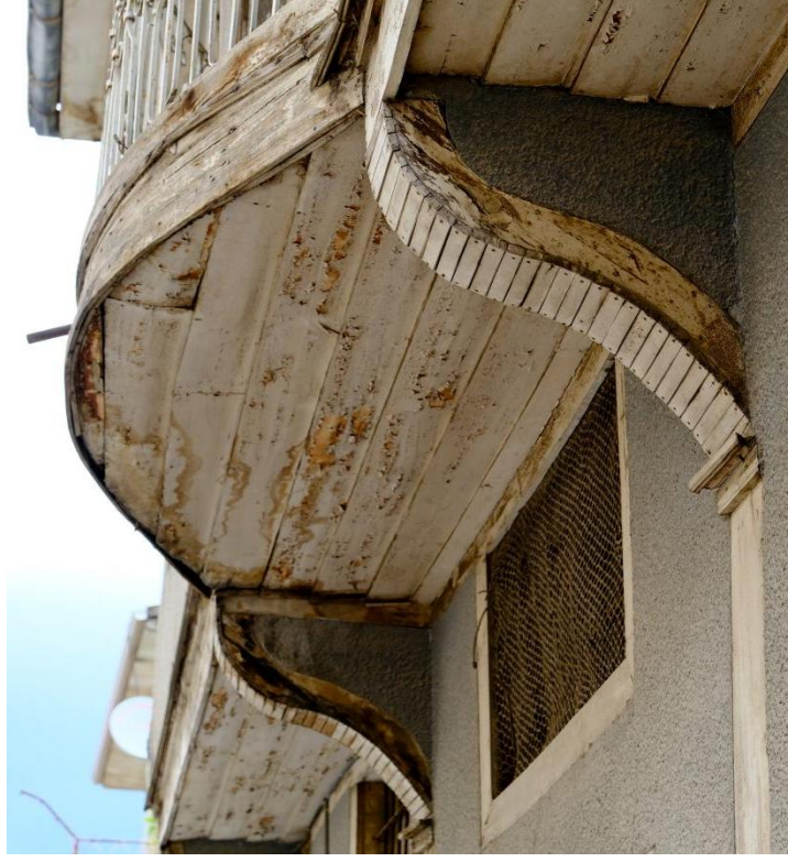
Görsel 45. Zile evlerinde bağdadi teknik ile yapılmış ahşap konsol çıkması. Aybike Nur Kılıçgil fotoğraf arşivi. 2022.
