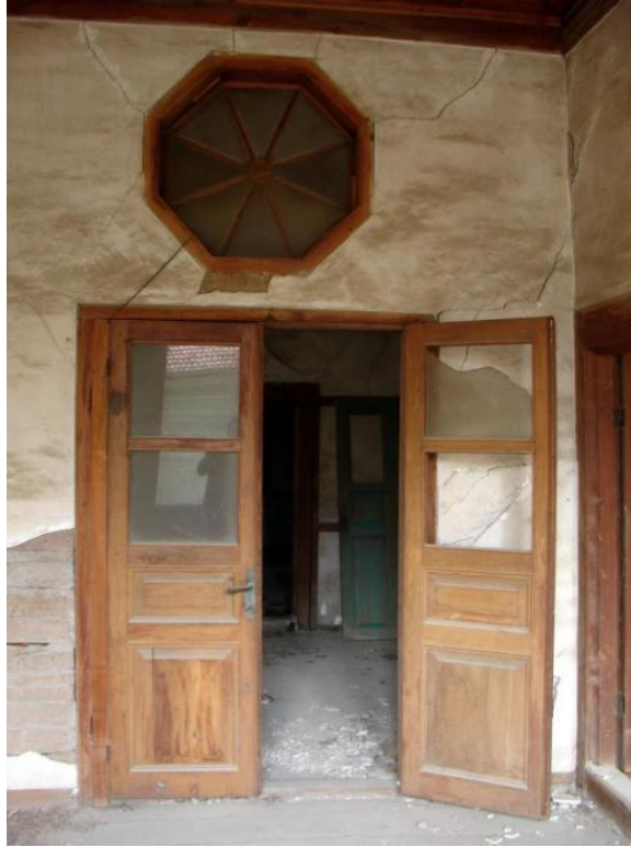
Görsel 82. Gaydaroğlu Konağı Sanat Merkezi, 1-02 oda bölümünün güney cephesinden Z-01 sofa bölümüne geçilen restorasyon öncesindeki iki kanatlı ahşap kapı ve geometrik tepe penceresi. Necmettin Eryılmaz fotoğraf arşivi.
