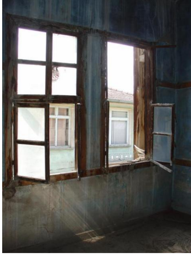
Görsel 85. Gaydarođlu Konađı Sanat Merkezi, 1-01 oda bölümünün batı cephesinde bulunan ½ oranında yapılmıř restorasyon öncesindeki ahřap pencereler. Necmettin Eryılmaz fotoğraf arřivi.
