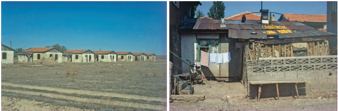
Görsel 20. Kıranköy'de boş kalan konutlar (solda), Gökler köyünde ek yapılar olarak kullanılan konutlar (Oliver, 2006, s. 231–2)
