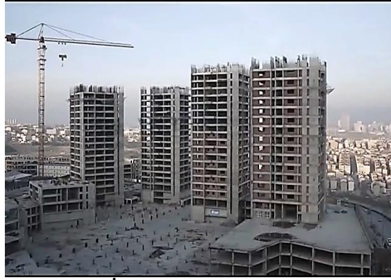
Görsel 13: İbrahim'in çalıştığı şantiye sahası
