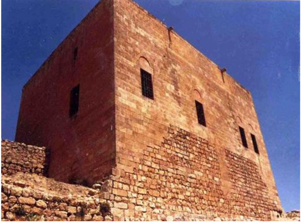
Fotoğraf 37. Zairi Camisi Güney Cephe (V.G.M Arşivinden, 2007)
