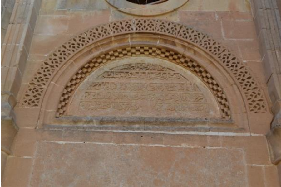
Fotoğraf 68. Zairi Camisi Giriş Kapısı Üzerindeki Yarım Daire Kemerli Alınlık (Alan,2021).
