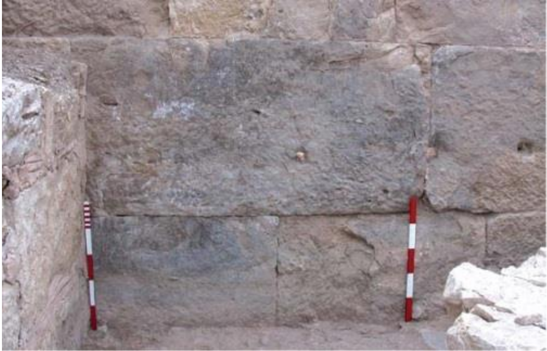
Res: 30. Kilisenin kuzey duvarında görülen demir kenet delikleri ve yangın izleri. Kaynak: Chris and Mûcahide Lightfoot, 2006
