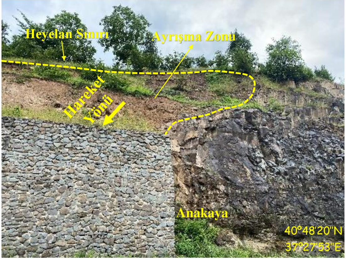
Şekil 4.3. Çalışma alanında ayrışma zonunda meydana gelmiş olan heyelan
