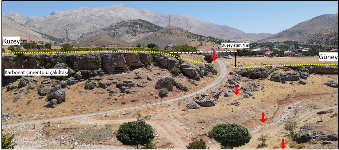
Şekil 5.19. Çardak Fayı'nın Barış Mahallesi civarında gözlenen alüvyon yelpazesinde meydana getirdiği düşey atım (bakış doğuya).
